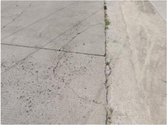
图 1-5 板角断裂
