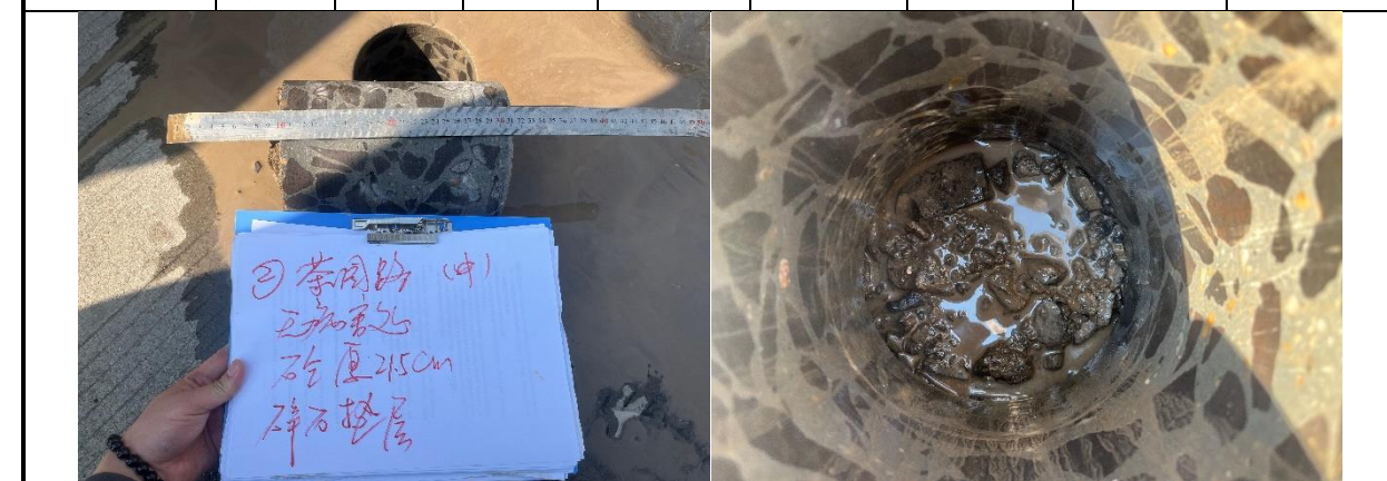
K0+580 处,板宽 3.5m,水泥砼面层厚度 21.5cm,成型较好,基层为碎石未取出。
