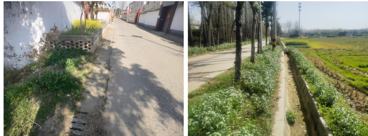
图 13 路侧 U 型渠、盖板边沟
