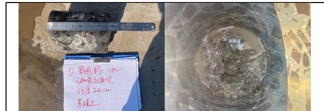
K1+180 处,板宽 3.5m,水泥砼面层厚度 20cm,成型较好,基层为素土未取出。
