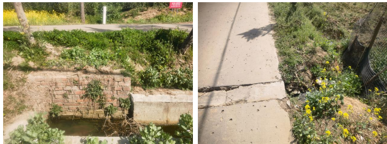
图 14 道路沿线管涵
