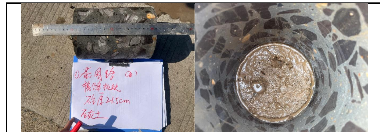
K0+100 处,板宽 3.5m,水泥砼面层厚度 21.5cm,成型较好,基层石灰土未取出。
