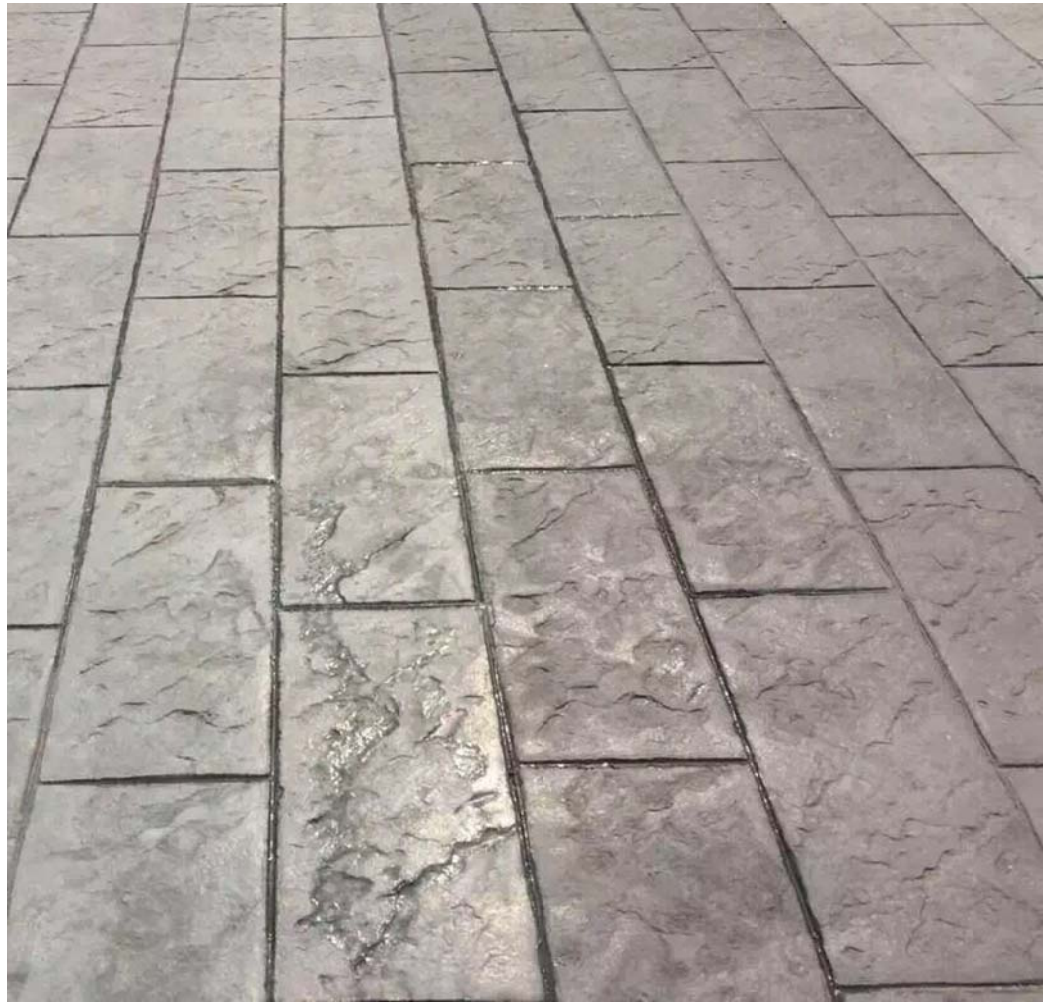
2 压膜混凝土样式1 SCALE
