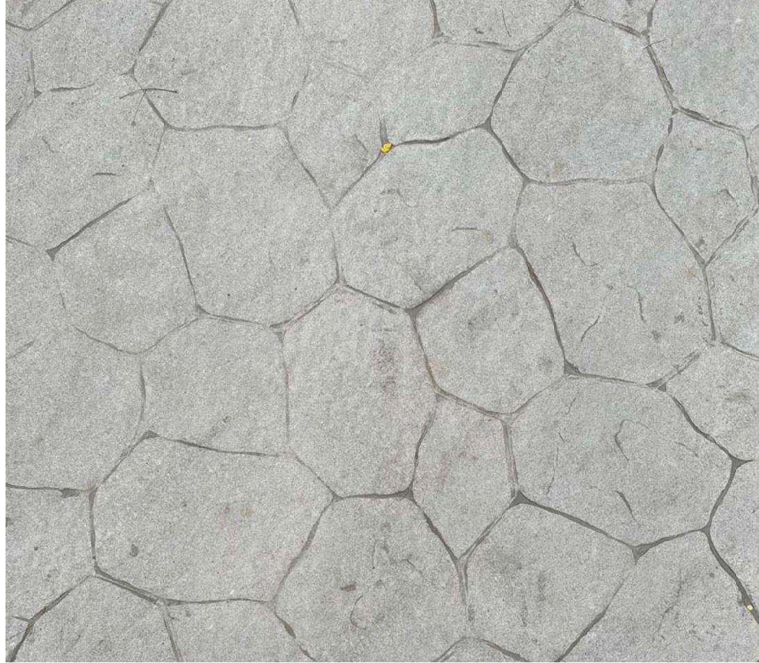
3 压膜混凝土样式2 SCALE
