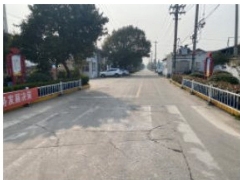
现状路基断面（罡郭线（二标段））
