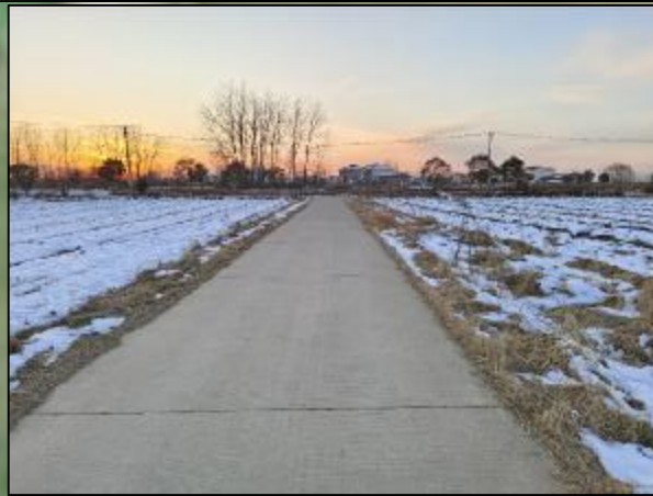
支线AK0+000-AK0+115段,老路路面宽3.5m
