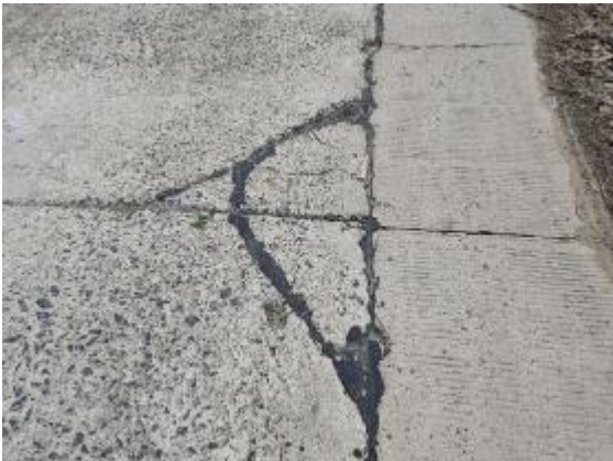
图 1-5 板角断裂
