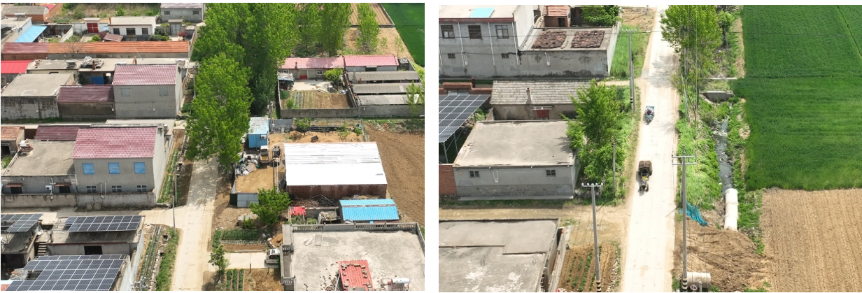
图 4-3 塔陡线道路现状图
