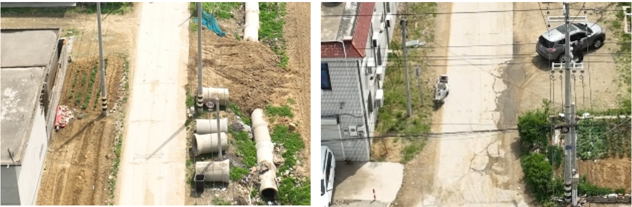
图 4-5 道路路面状况
