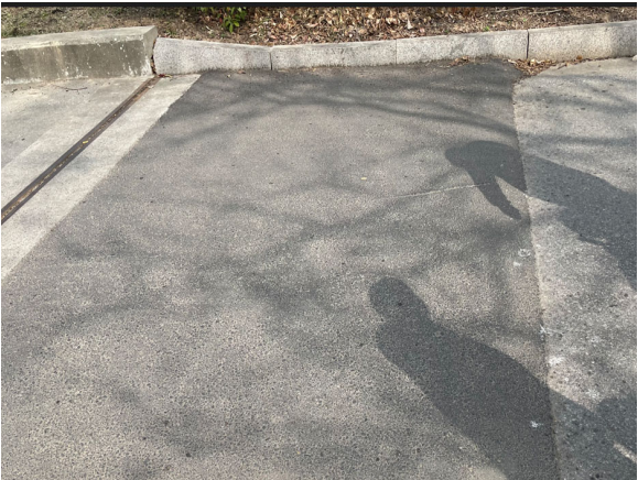
图 4-2 红旗路大华河桥桥头跳车
