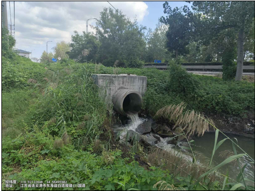
排水沟东侧现状 \phi 1000 管道
