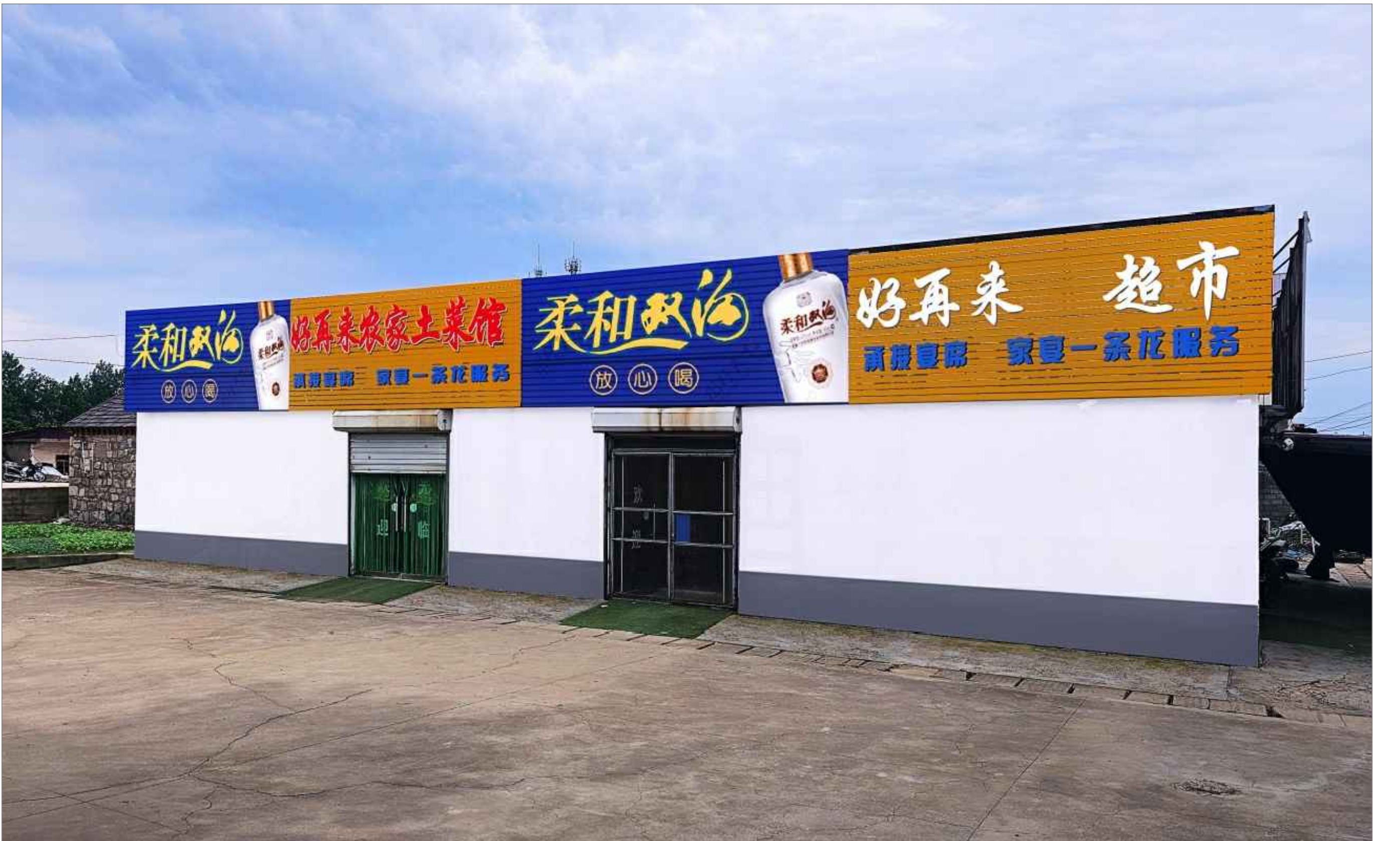
② 建筑外立面改造二
