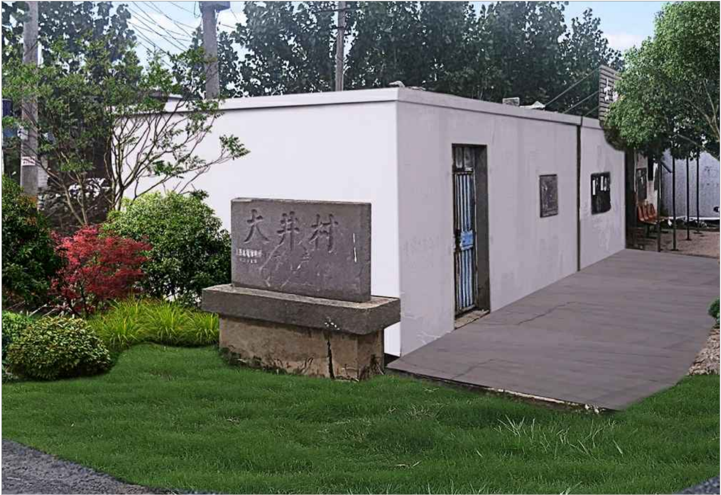
① 建筑外立面改造一
