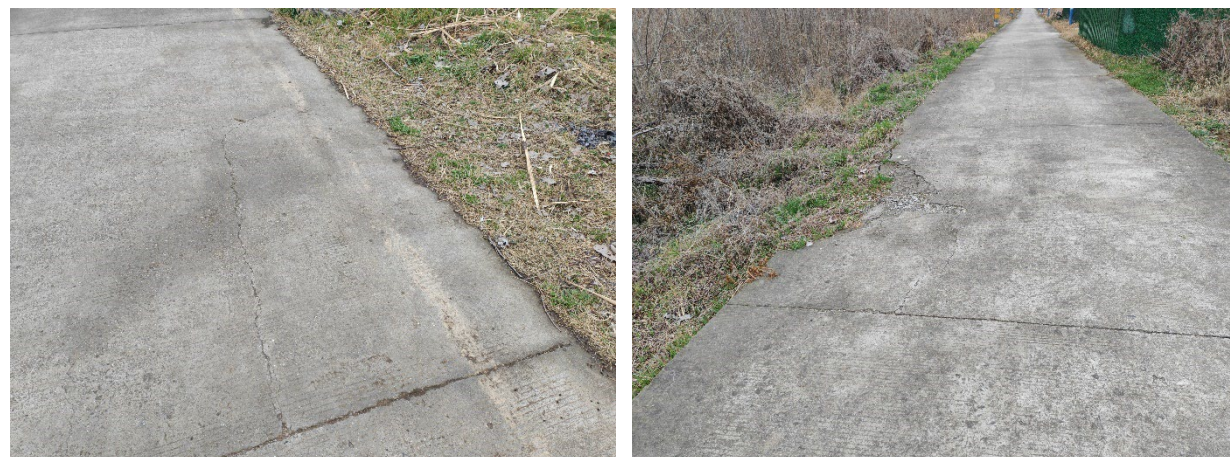
图 7 板角断裂
