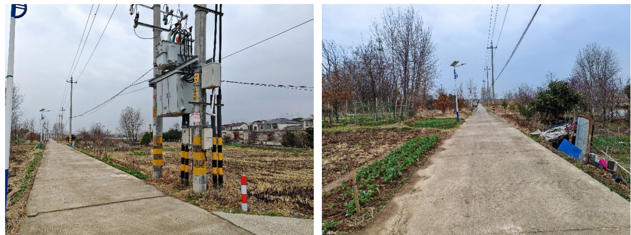
图 10 起点至 K0+415 段路侧杆线
