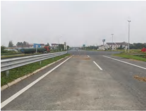
交叉口北侧 226 省道现状
