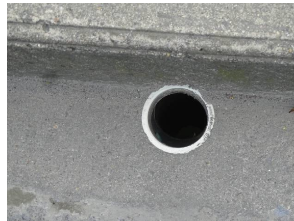
图 4-18 森园路老东河桥
