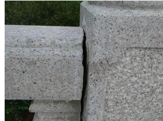
图 4-14 吴陵路吴陵桥 3#孔左侧人行护栏横梁杆件松动
