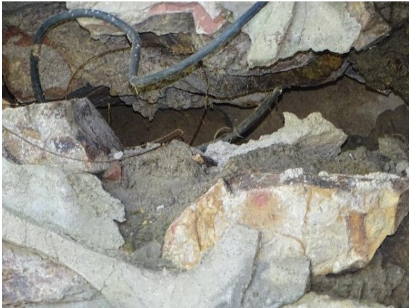
图 5-8 翼墙墙身横向开裂
