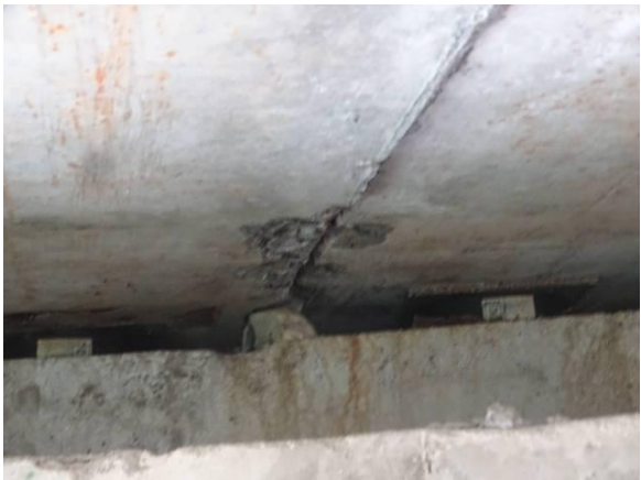
图 4-27 梅兰东路-林南桥 3-29#板梁底板南侧破损
