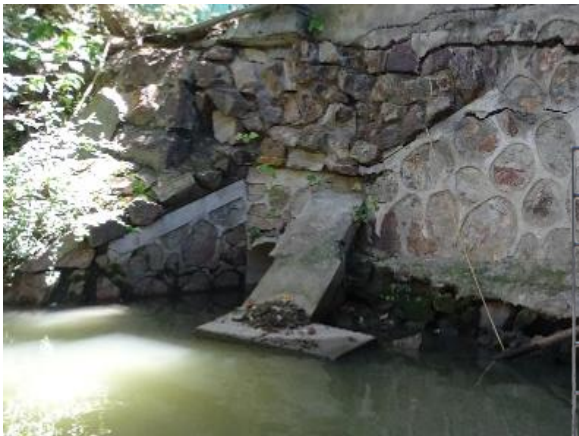
图 5-9 翼墙尾端下方排水口
