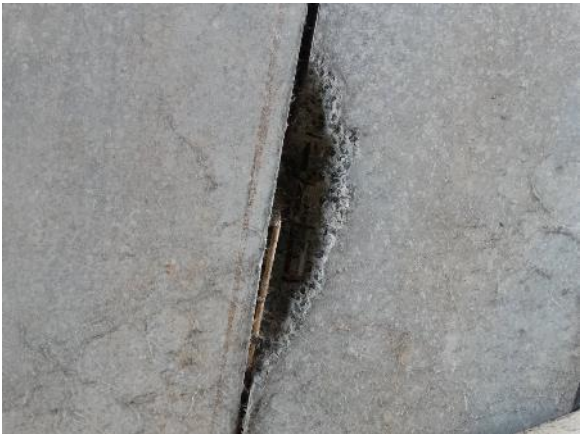
图 4-26 森园路老东河桥 2-11#梁底板破损
