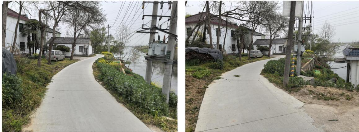
(3) K0+240~K2+130 段：现状老路宽 3.5m，现状老路路况良好，仅局部路段存在少量破碎板病害。道路北侧毗邻住宅区，局部路段存在矩形边沟。道路南侧紧邻沿山河。其中 K0+620~K0+640 段与 X201 平面相交。
