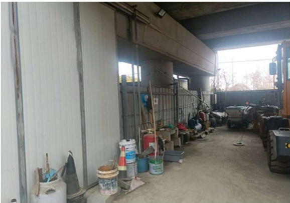
结构房屋违建
