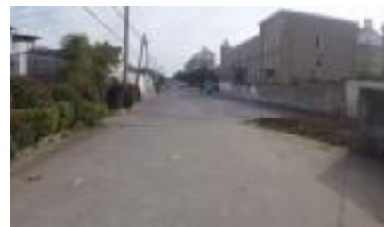
警告标志缺失
