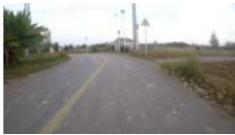
急弯警告标志未设置入弯道
