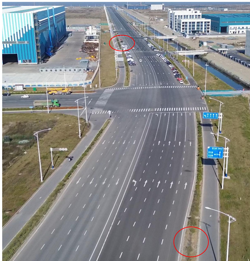
设施位置在东港东路与东港南路交叉口南北方向，设施取电从交叉口位置相变取电。
