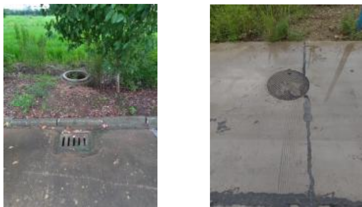
图 3-5 现场排水管道
