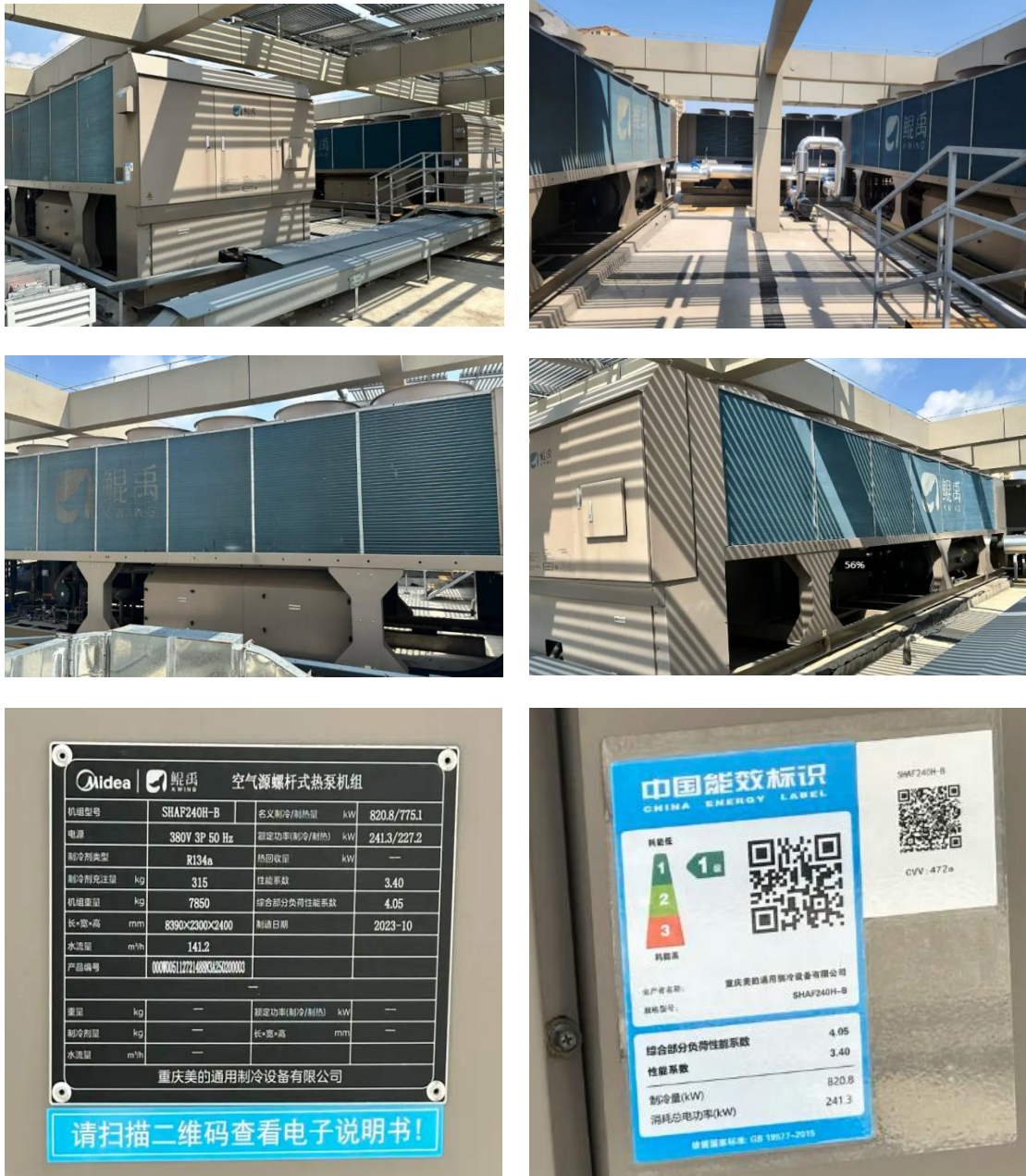
图 2.2.2-1 空气源螺杆式热泵机组及铭牌
