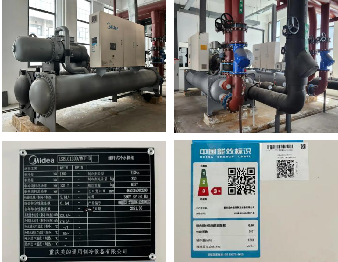
图 2.2.2-2 螺杆式冷水机组及铭牌
