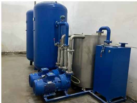
图 2.2.8-1 空压机、真空泵
