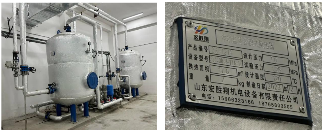
图 2.2.7-4 浮动盘管容积式换热器及铭牌
