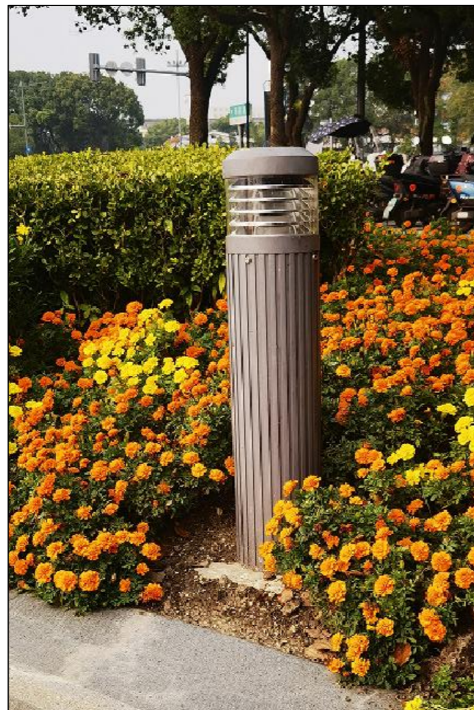
草坪灯： 高度800mm，灯杆截面尺寸 \phi 165 ，灯杆材质铝合金
