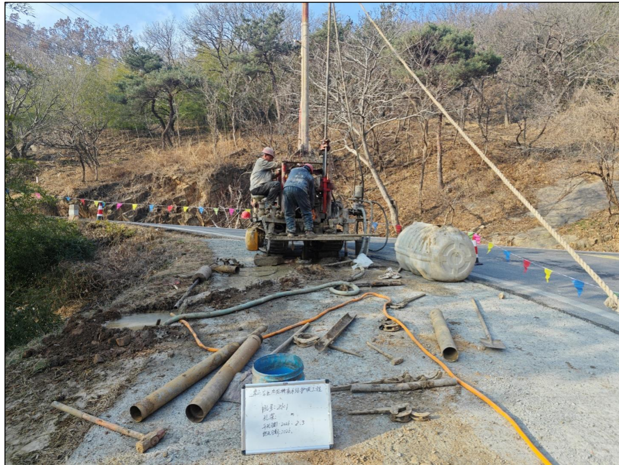
照片 1-1、钻探施工
