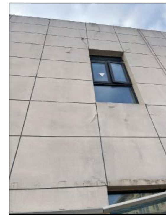
外墙漏水及破损的维修时，清除原有污损计破损的面层，重新粉刷找平，涂防水材料后，刮腻子后喷涂外墙涂料。
