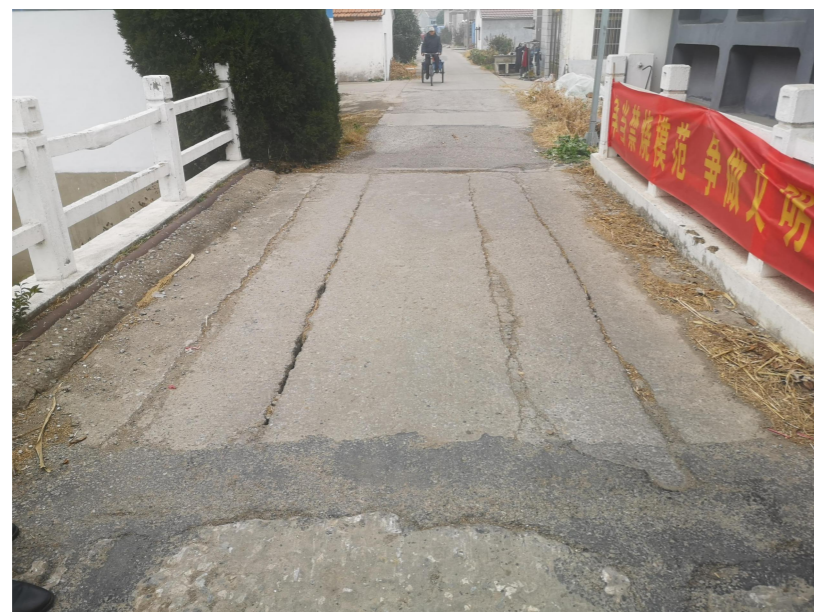
交通桥桥面现状
