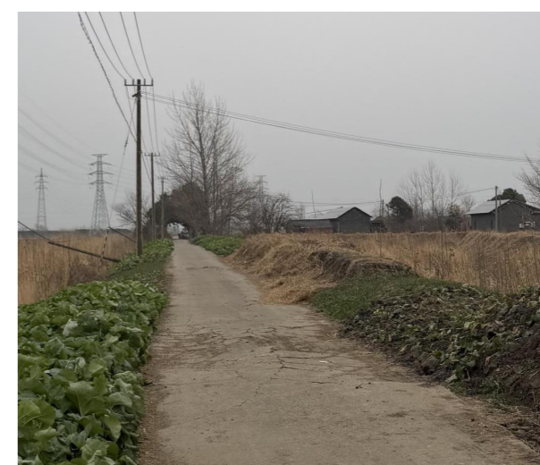
防汛道路现状2
