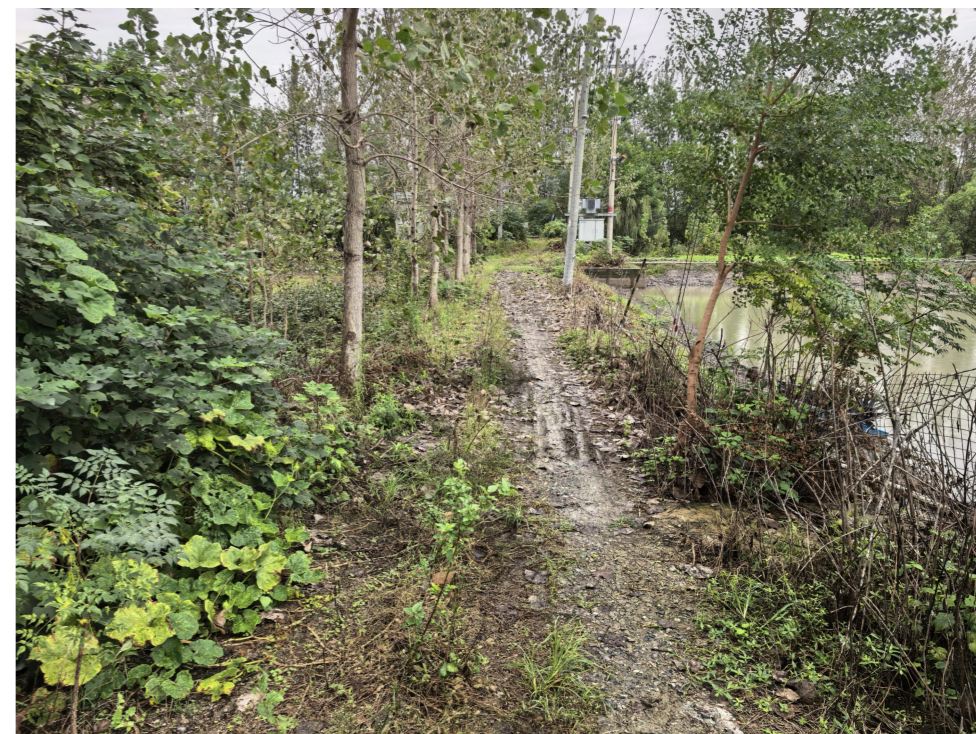
防汛道路现状
