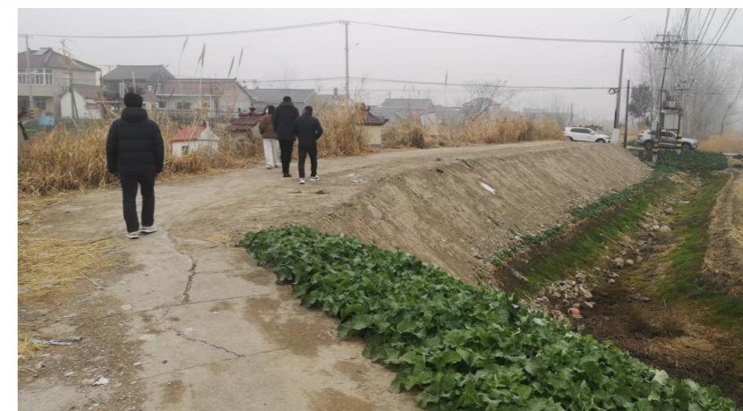
徐垛三组闸北侧防汛道路现状
