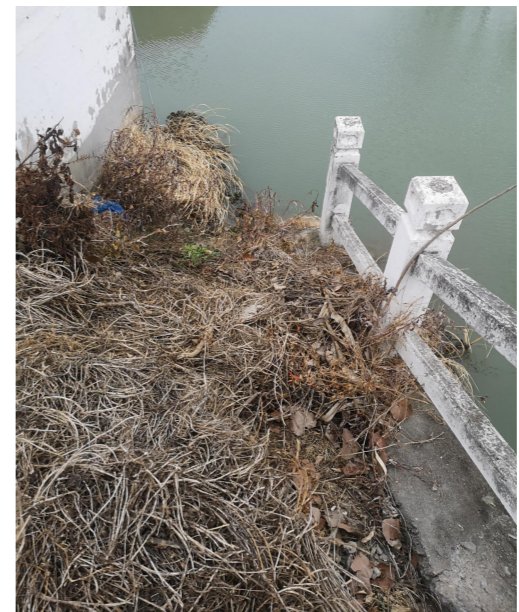
东侧斜坡现状坡面
