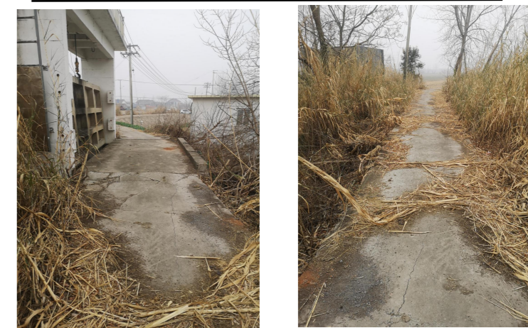
徐垛三组闸至徐垛西站防汛道路现状
