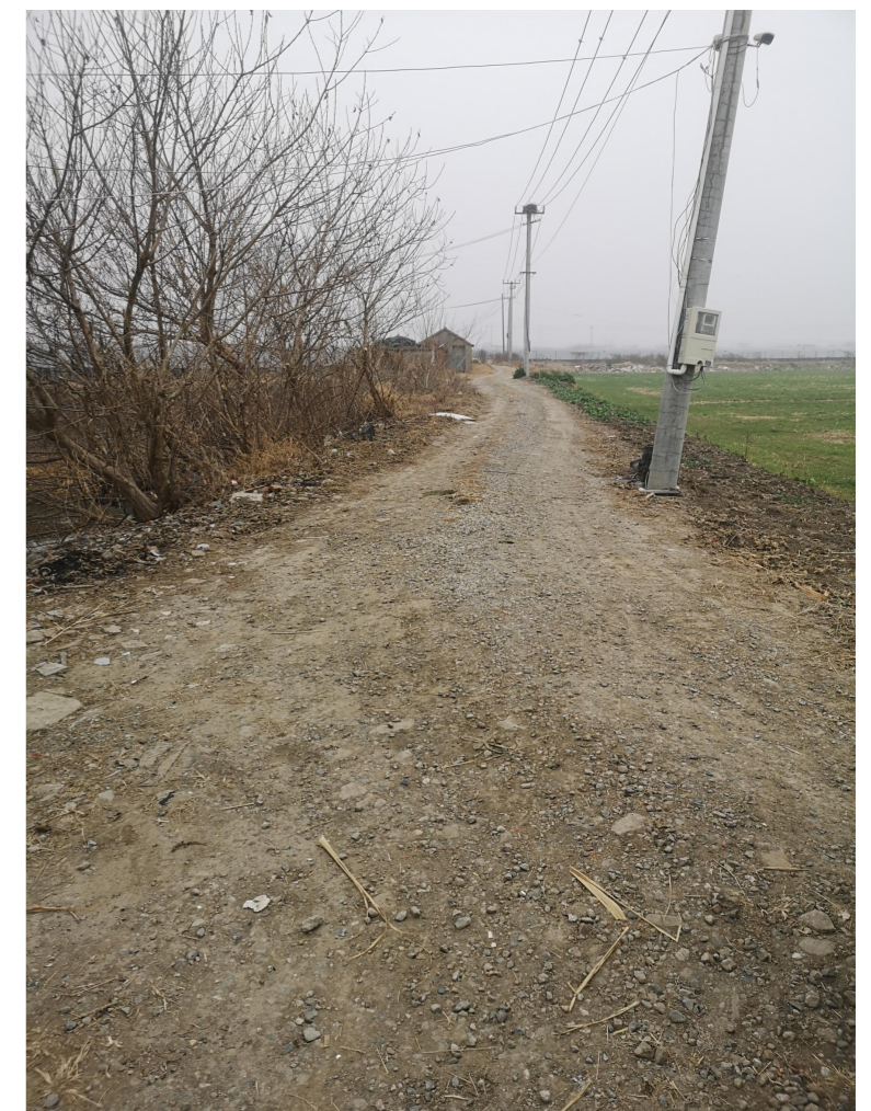
防汛道路现状
