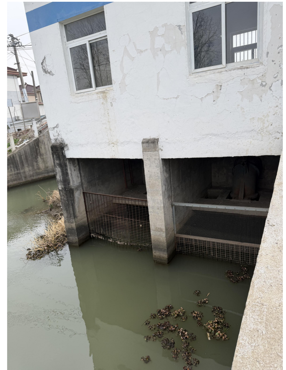
西楼排涝站处拦污栅现状
