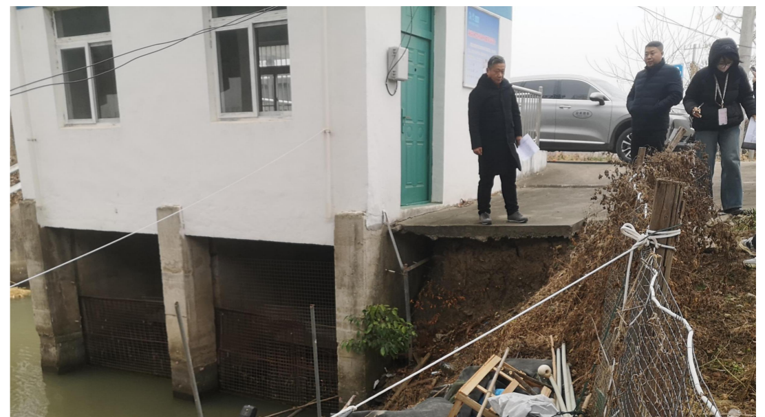
门前地坪整体现状
