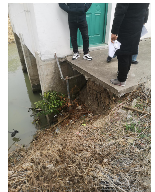
地坪下方现状
