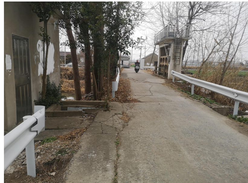
门前以南（至庄中西闸）防汛道路现状
