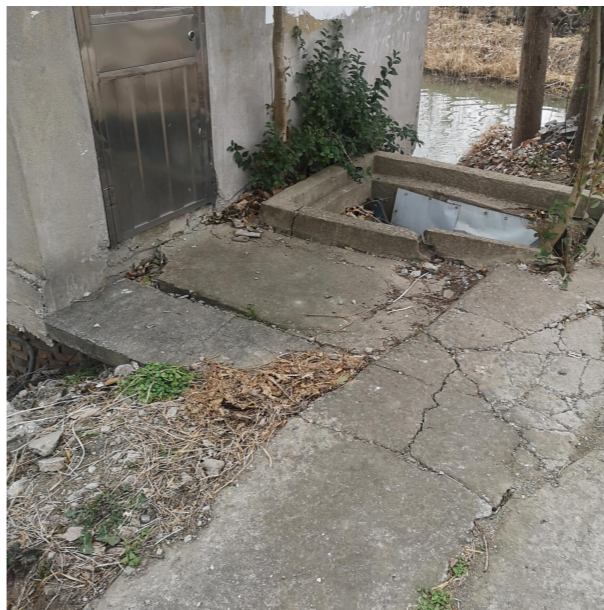
门口地坪和出水池现状
