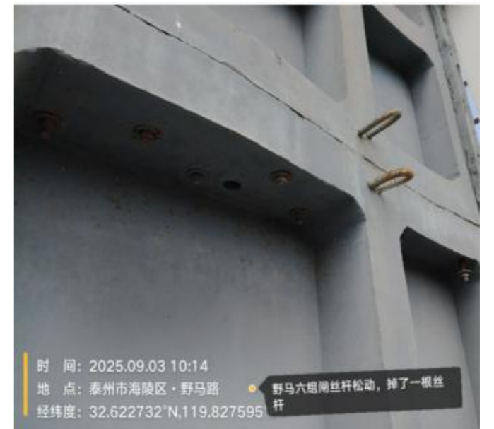
野马六组闸现状
