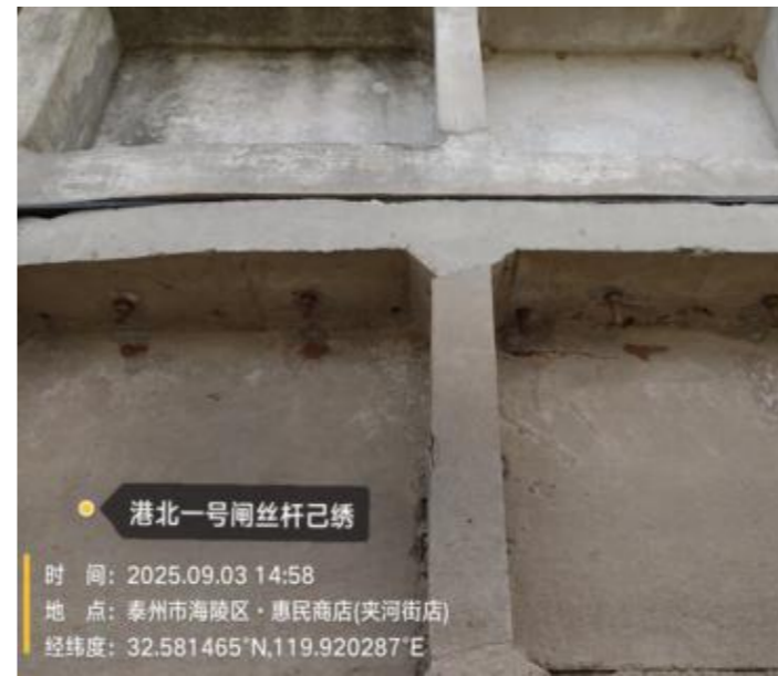
港北一号闸现状
