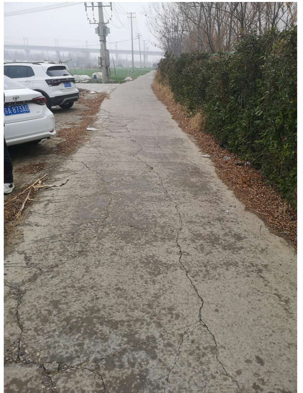
防汛道路现状1
