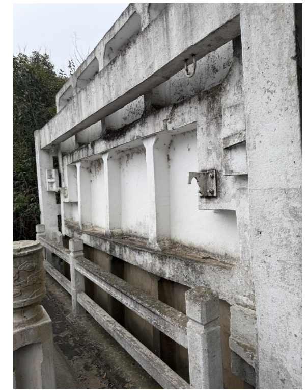
上部结构现状2
