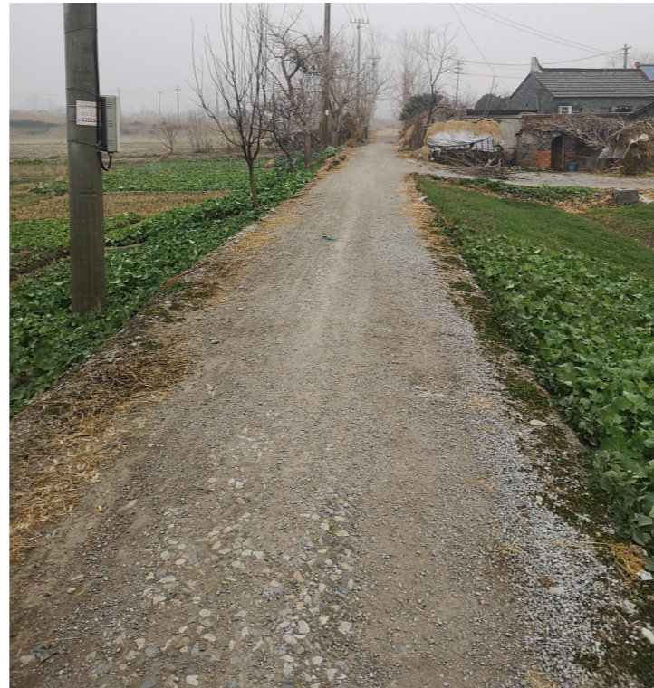
防汛道路现状2
