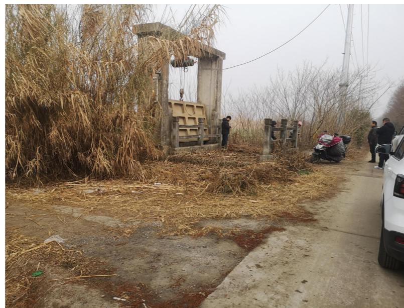
交通桥与两侧道路现状
