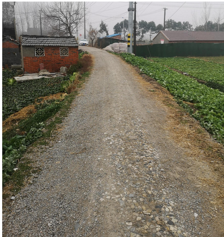
防汛道路现状1
