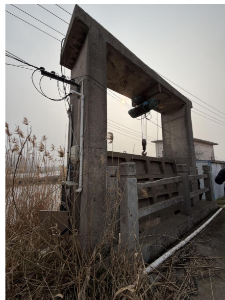
上部结构现状
