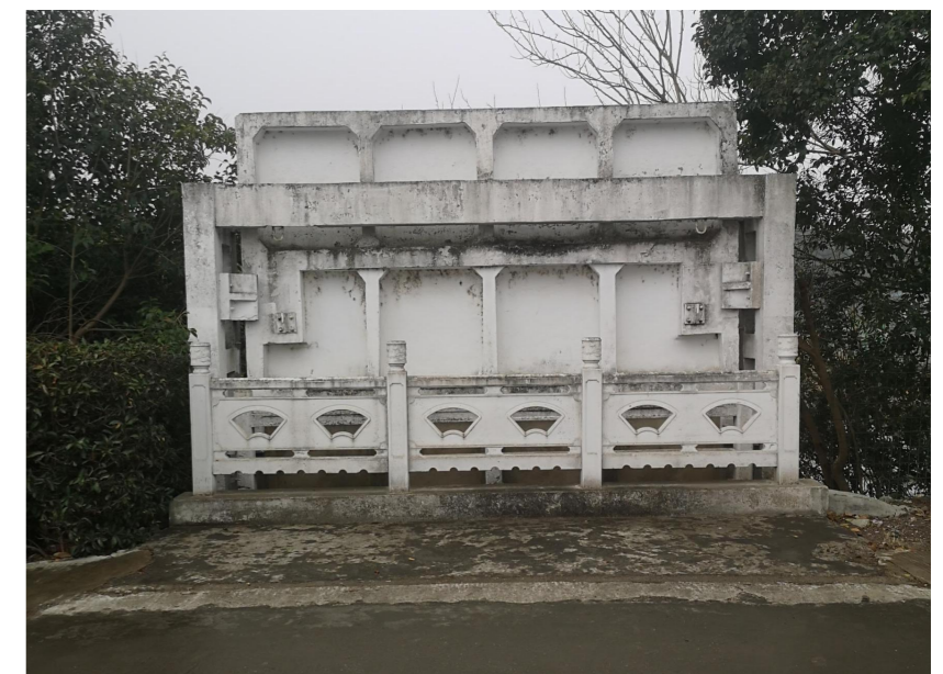
上部结构现状1
