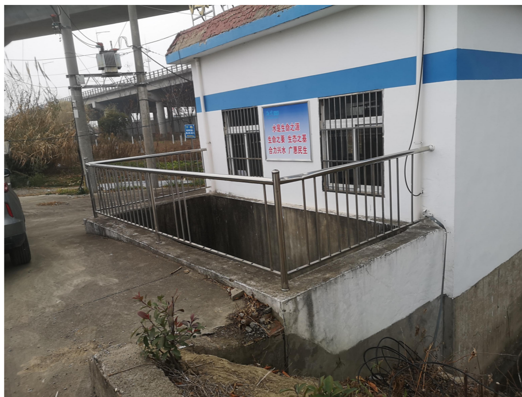
东楼排涝站东侧水池栏杆现状
