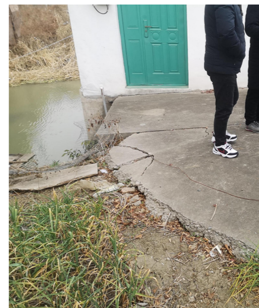
门前地坪现状
