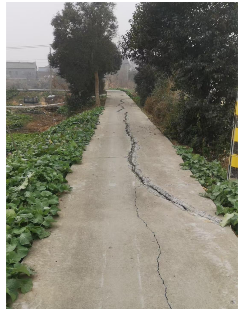
防汛道路现状
