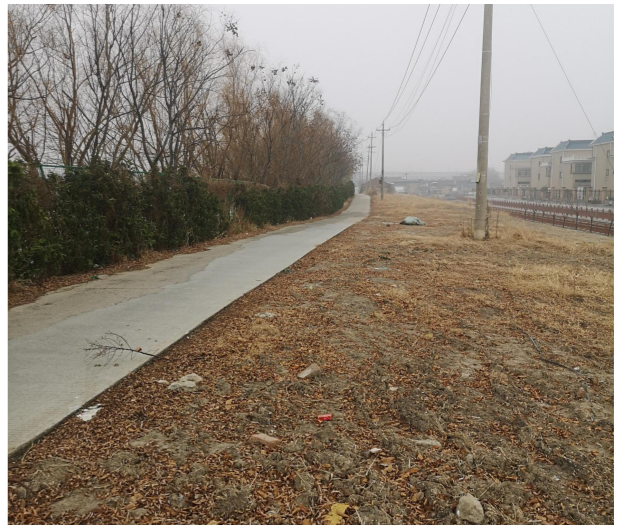
防汛道路现状2
