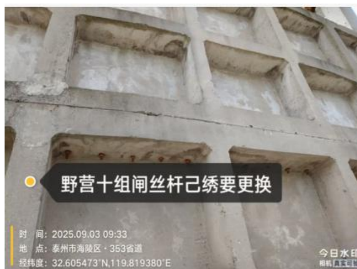
野营十组闸现状
