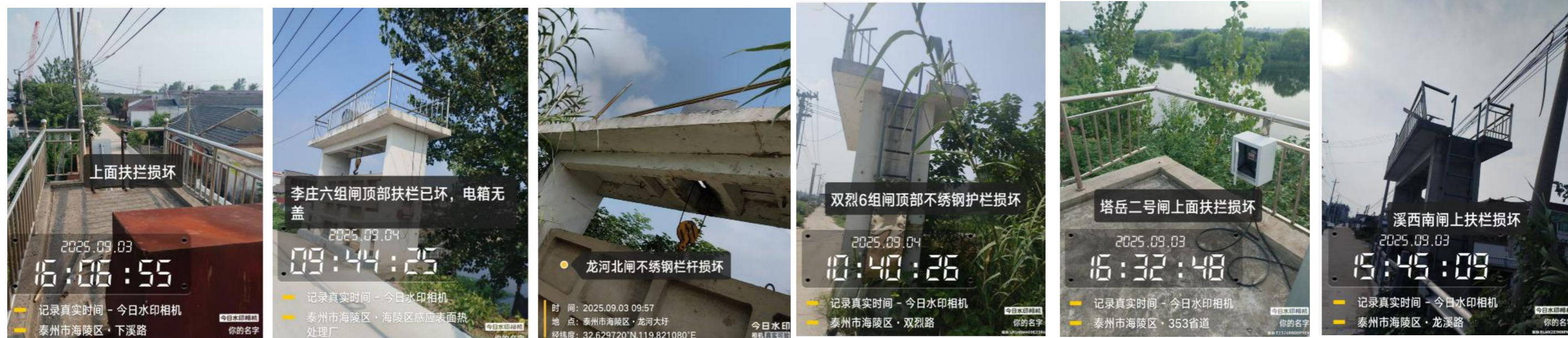
各闸工作桥栏杆现状
