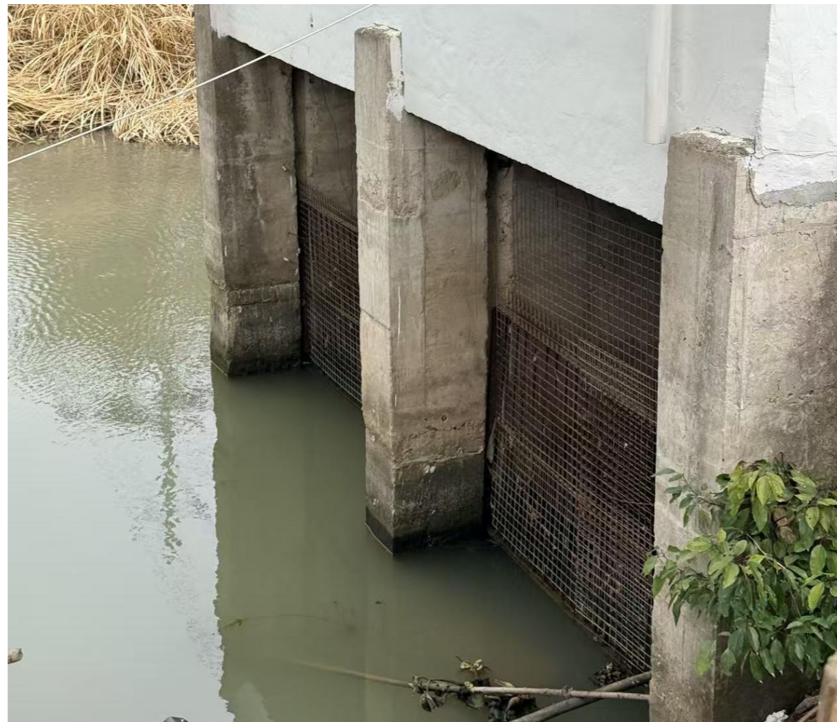
东楼排涝站处拦污栅现状
