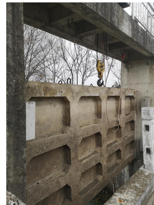
交通桥栏杆现状2
