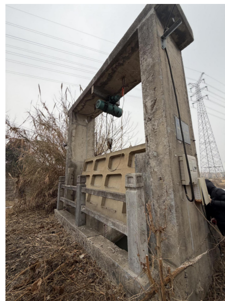
上部结构现状
