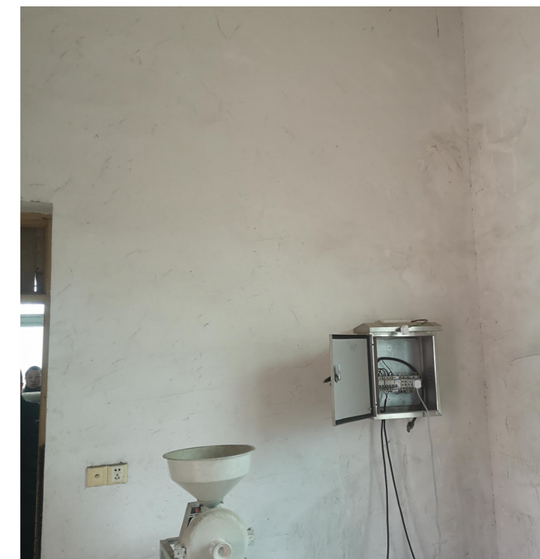
站内墙壁现状
