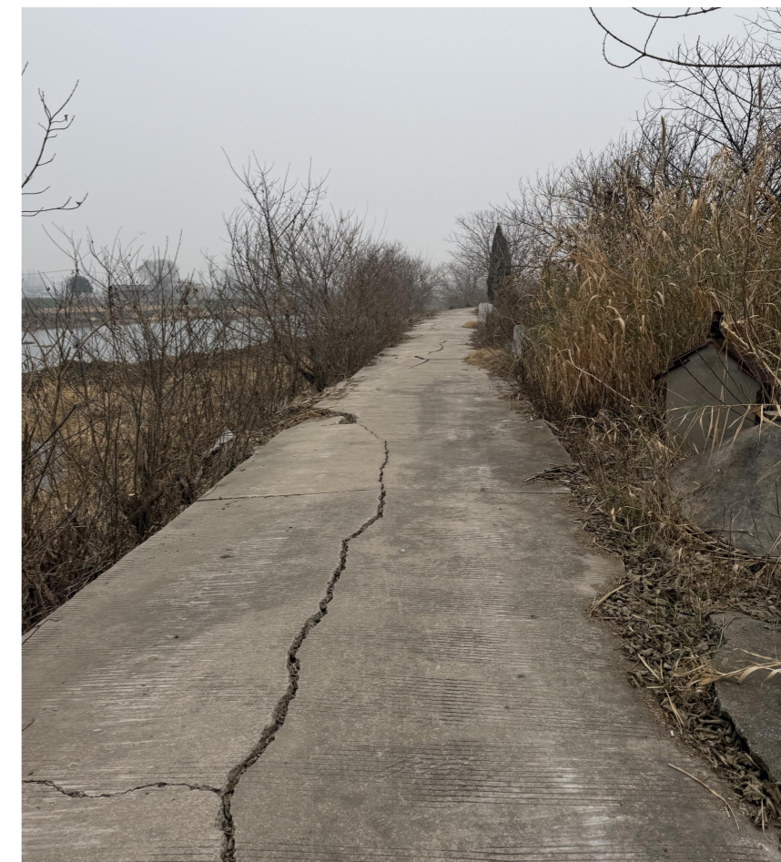
许庄东闸东侧防汛道路现状
