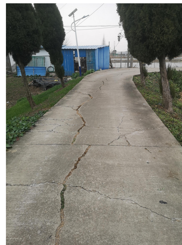
防汛道路现状1
