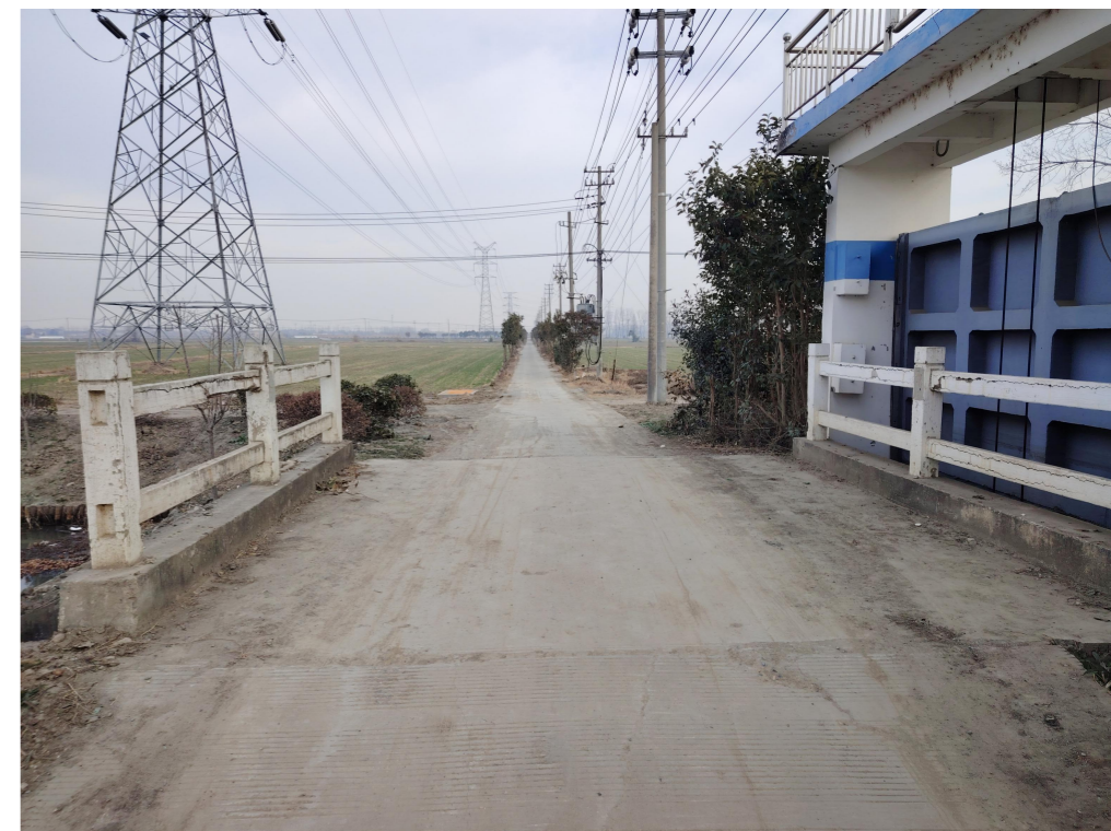
八十亩沟闸桥栏杆现状
