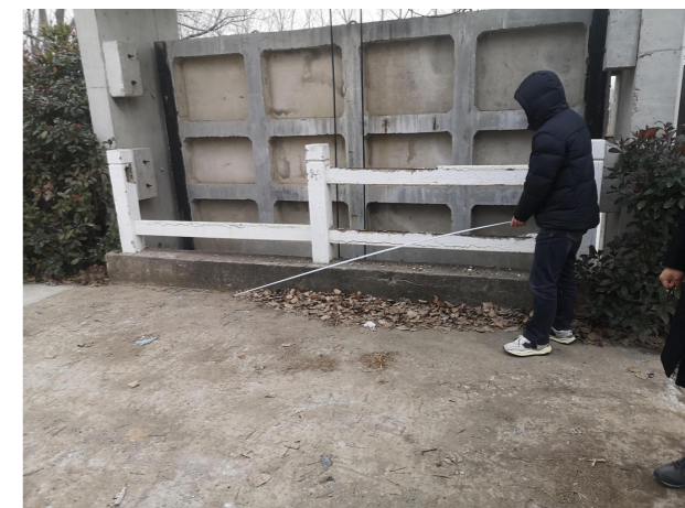
交通桥东侧栏杆
