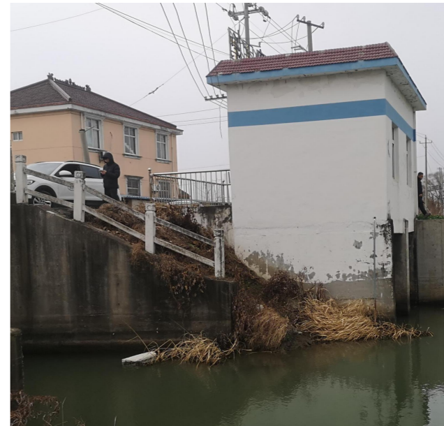
东侧斜坡现状侧面
