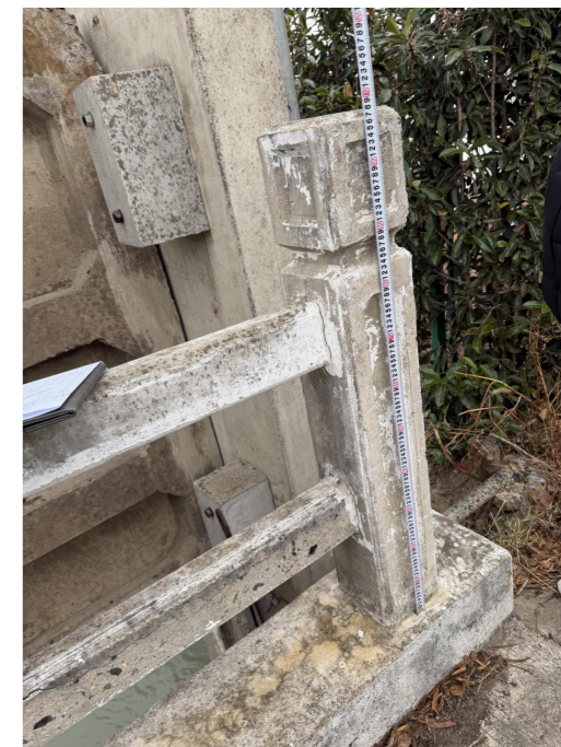
交通桥栏杆现状1
