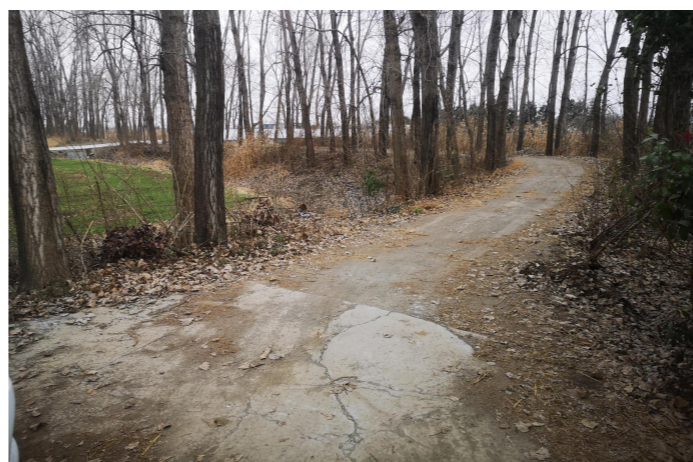
闸站北端防汛道路现状
