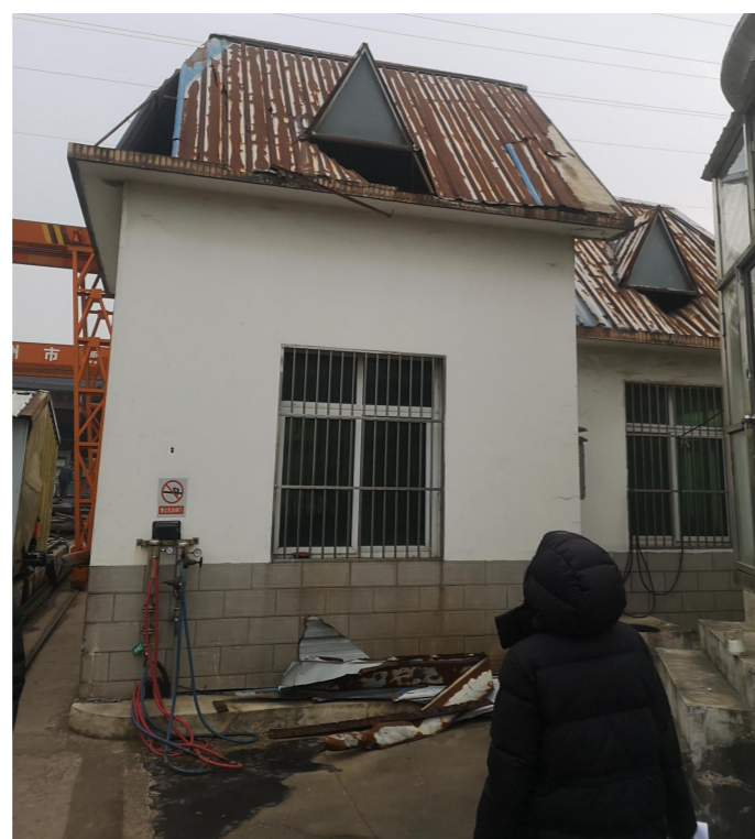
泵站屋顶现状
