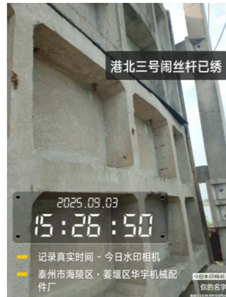
港北三号闸现状
