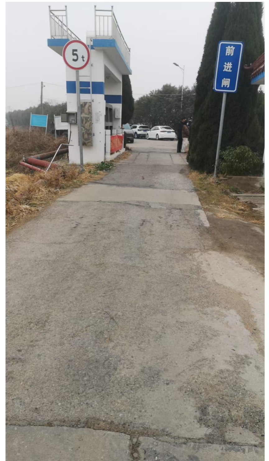
交通桥两侧与道路接线处现状
