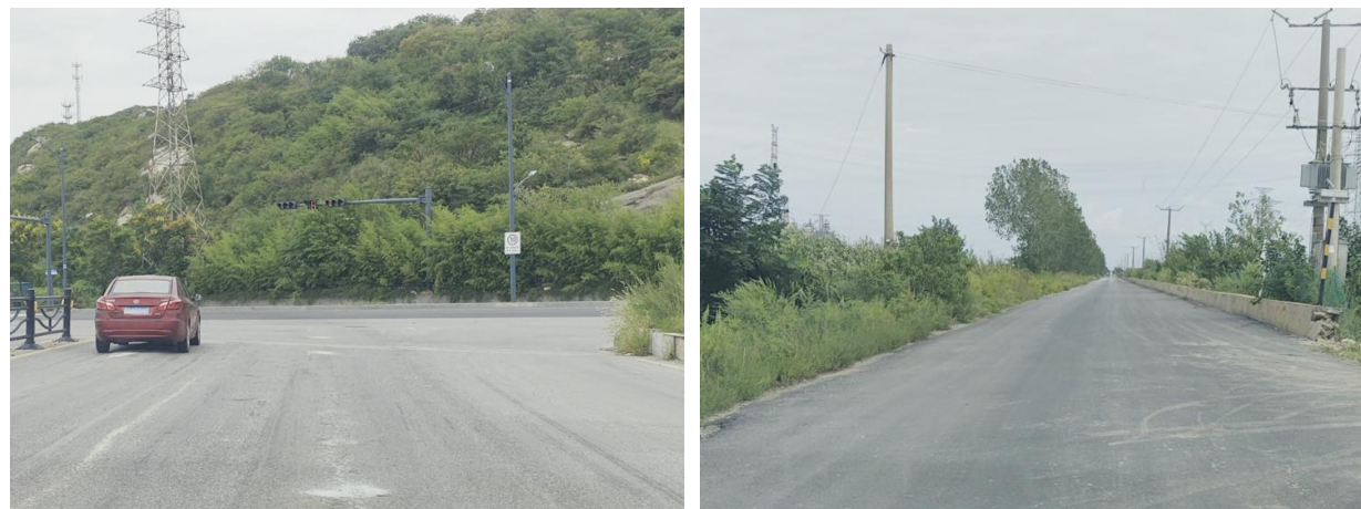
2) 部分搭接道口处缺少交叉警告标志、诱导标志等。
