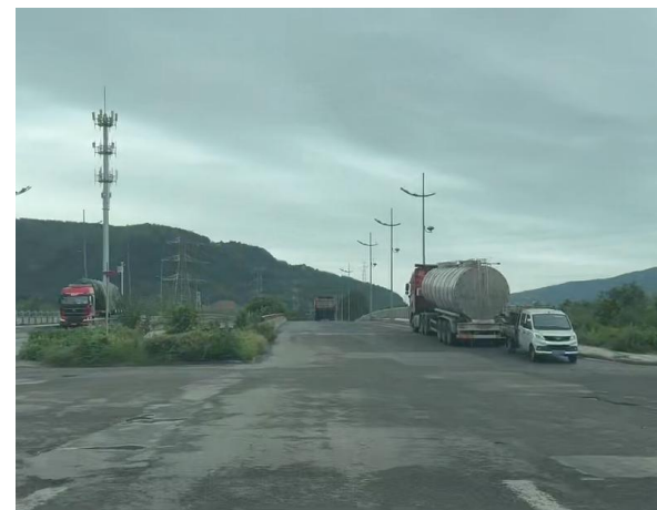
经十五路标线磨损、缺桥梁限重
