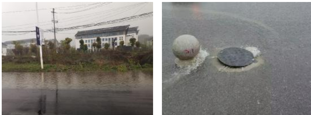
图2-16 道路积水、架空杆线、污水顶托
