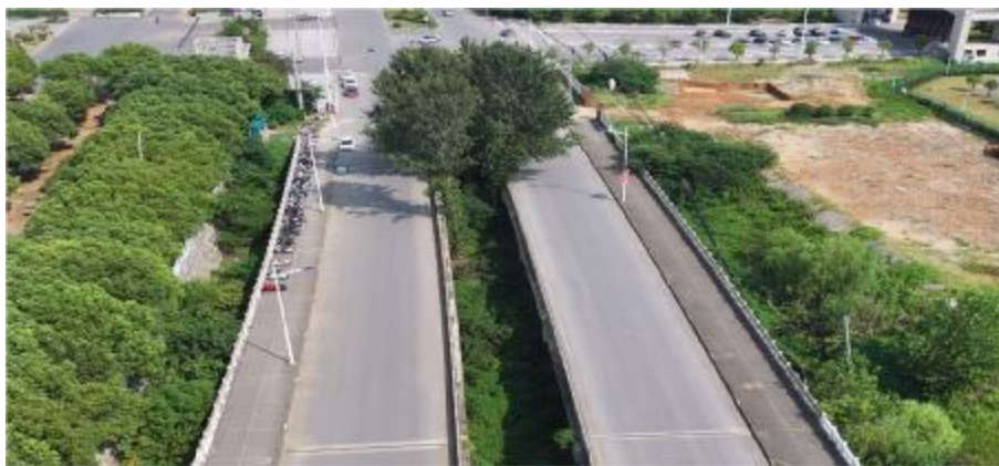
图5-34 桥梁现状照片
