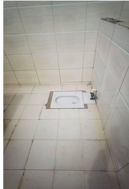
改造前：洁具和瓷砖破损
