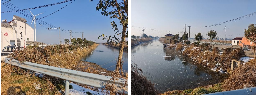
图 1.2-33 西排河现状照片
