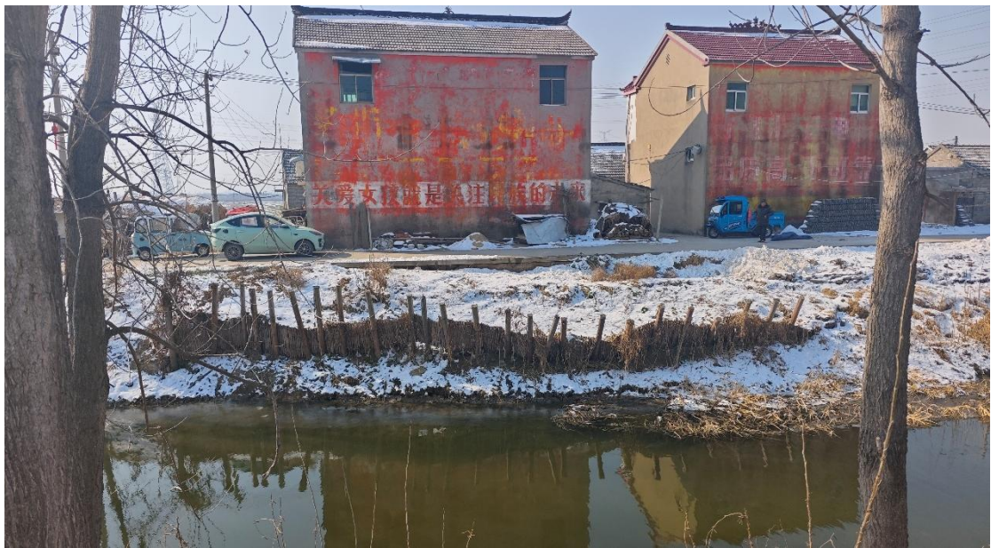
图 1.2-25 中溪河现状照片
