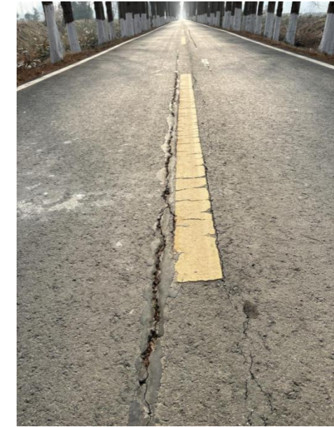
图 4-3 纵向裂缝
