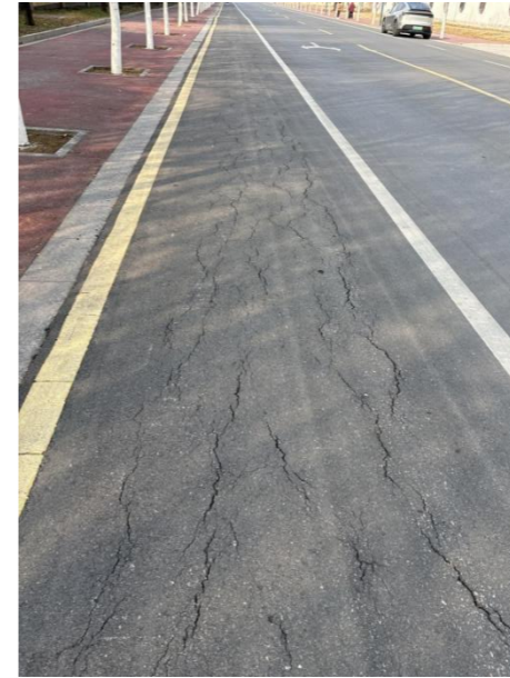
图 4-2 纵向裂缝
