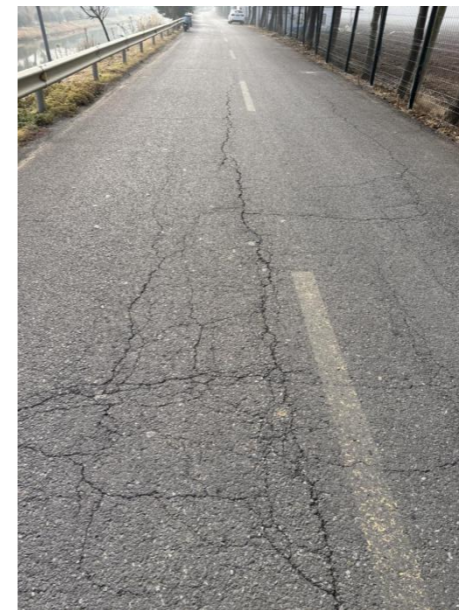
图 4-2 纵向裂缝
