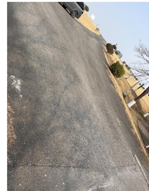
图 4-3 纵向裂缝
