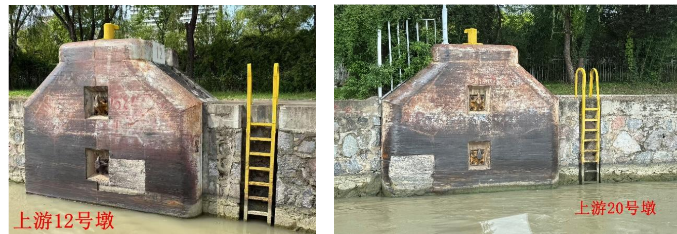
图 2-8 三号船闸上游靠船墩现状图
