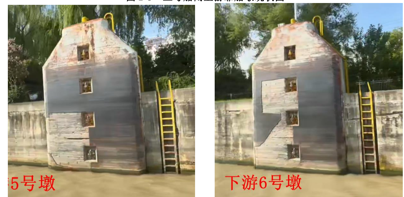
图 2-9 三号船闸下游靠船墩现状图
