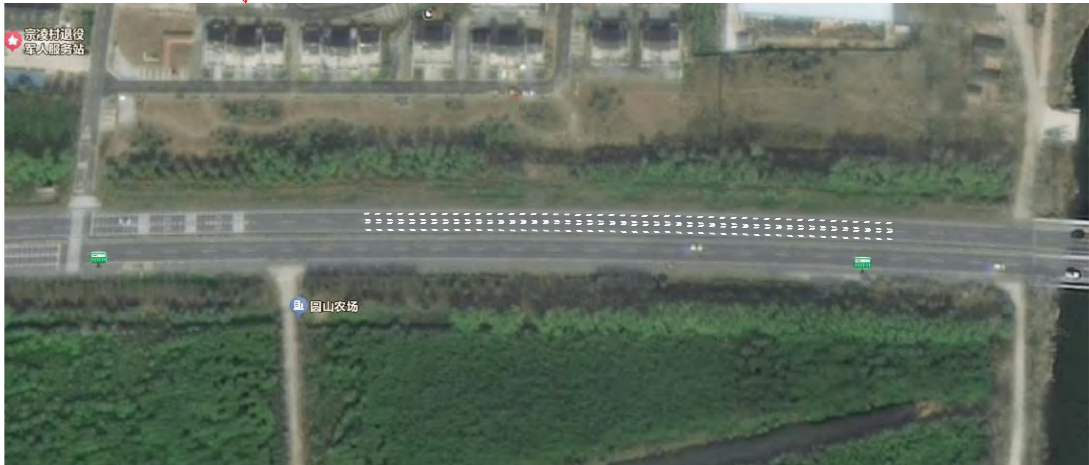
桩号K1+300~K1+500由东往西下坡段，施划纵向减速标线，面积约120平
