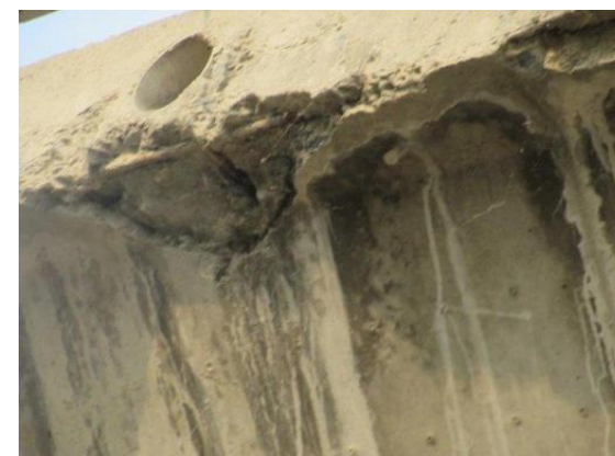
图2.2.2-1 1-1#梁剥落掉角
