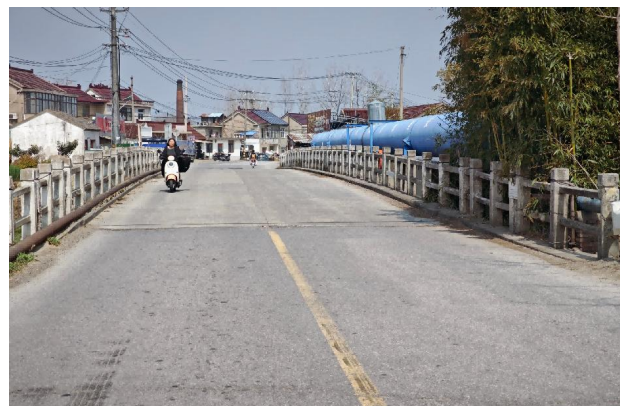
图2.2.1-2 坡岭桥正立面照
