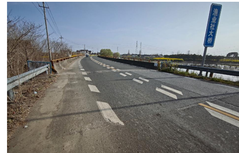
图2.5.1-1 渔业社大桥正立面照
