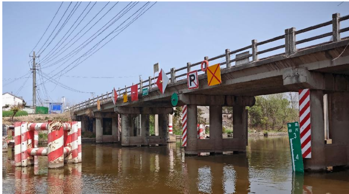
图2.2.1-1 坡岭桥侧立面照
