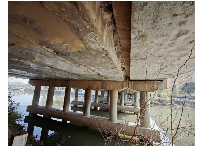
图2.6.1-3 光明大桥底面照
