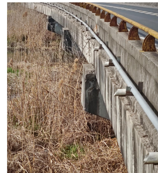
图2.5.1-2 渔业社大桥侧立面照
