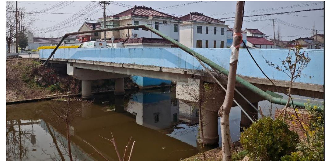
图2.3.1-1 尹庄桥侧立面照
