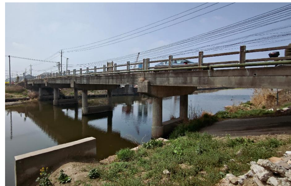
图2.4.1-1 大窑桥侧立面照
