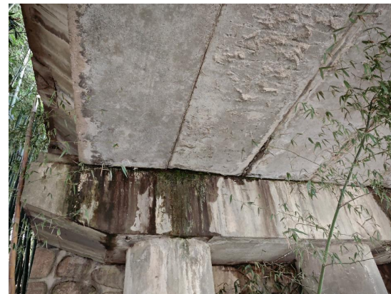
图2.2.1-3 坡岭桥底面照
