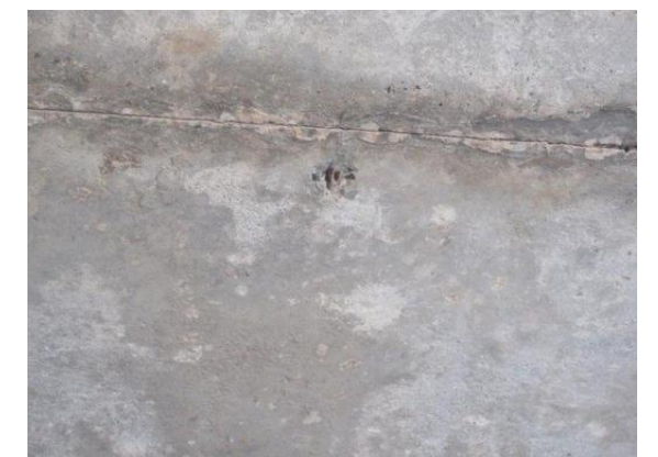
图2.2.2-2 1-3#梁剥落掉角
