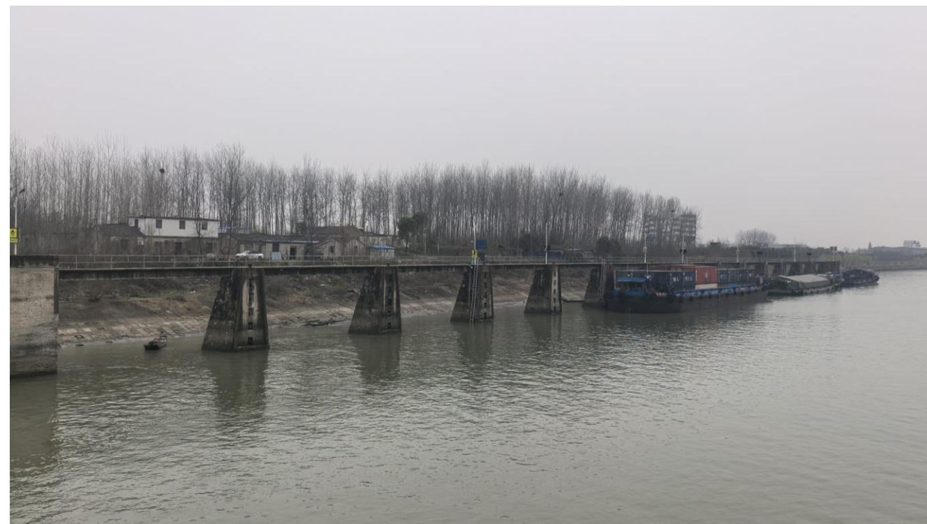
图 2-4 靠船墩现状总览图（1）
