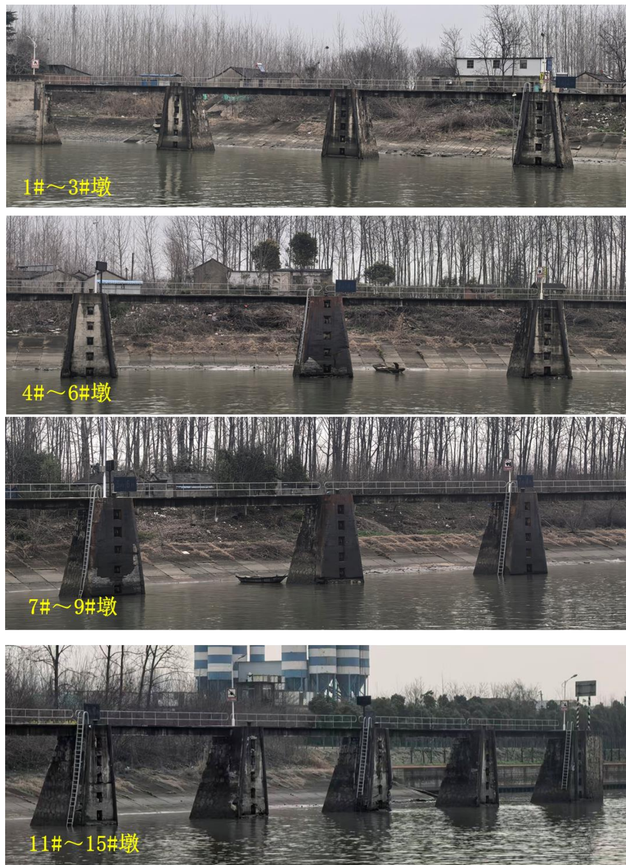
图 2-5 靠船墩现状总览图 (2)
