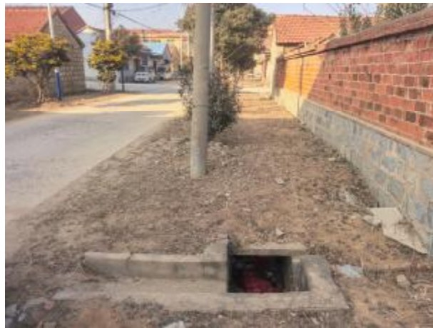
双河村排水沟照片
