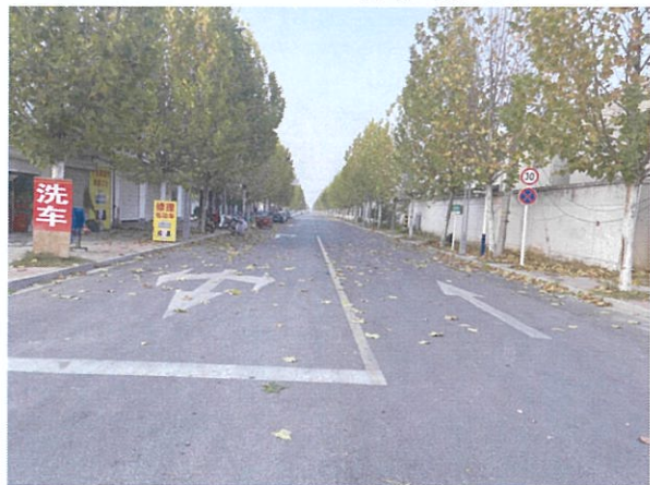
常州路（上行支线）现场照片
