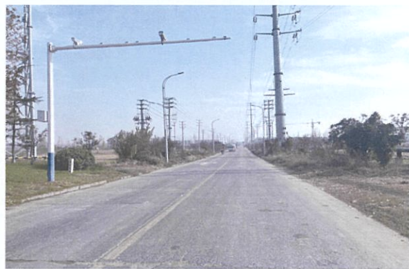
东侧被交道路现场照片
