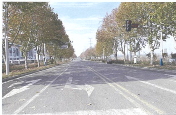
西侧被交道路现场照片
