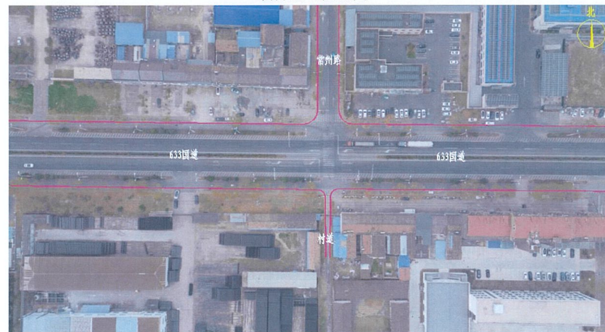
交叉口现状航拍图
