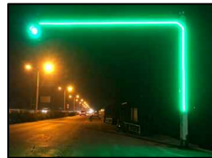
安装于现状信号灯杆
