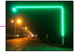
安装于现状信号灯杆
