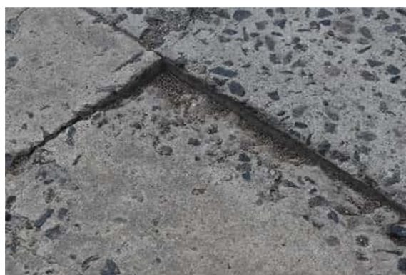
图 4.6-7 桥面坑槽
