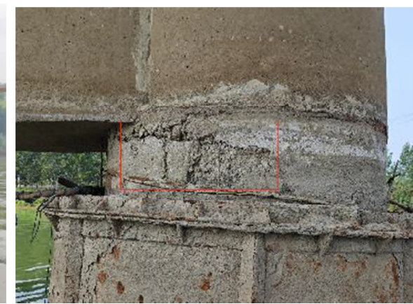
图 4.2-12 5-2#桩顶砼破损
