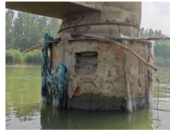
图 4.2-11 3-2#钢套筒内部掏空
