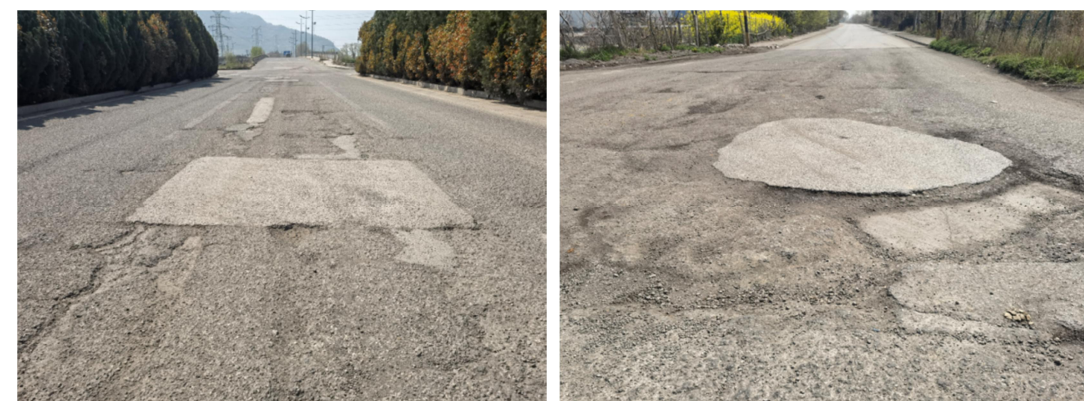
大面积修补、坑槽
