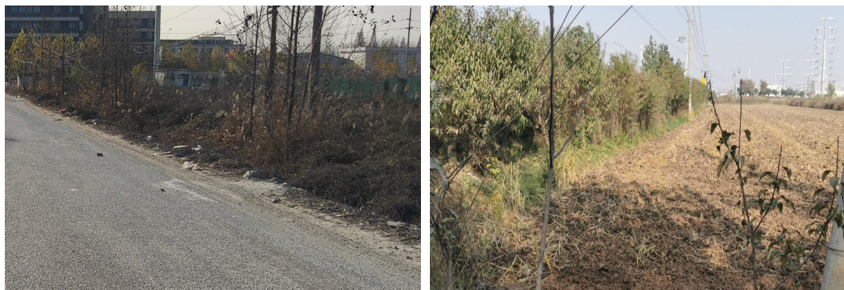
图 3-5 排水设施现状
