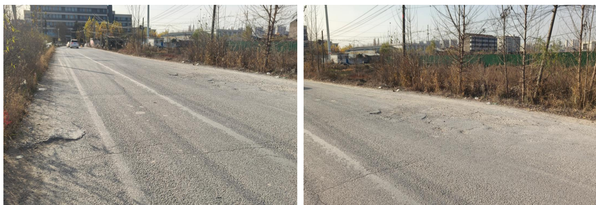
图 3-6 路基防护现状
