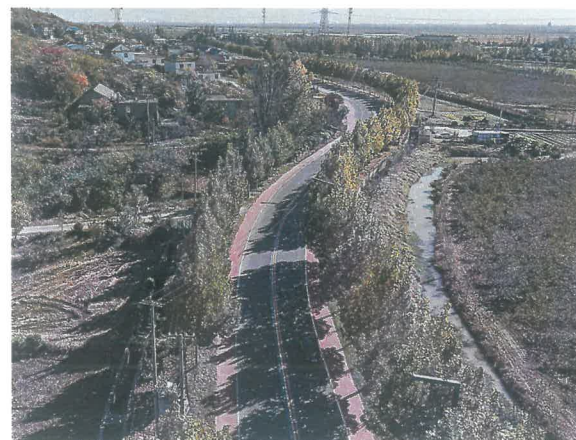
缺少急弯警告、线型诱导、限速标志，缺少减速标线。
