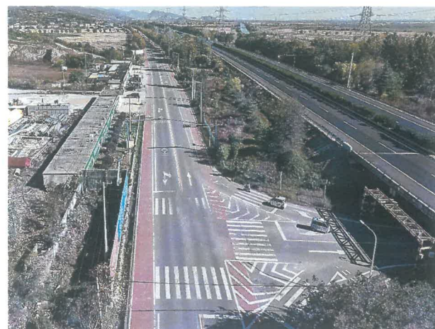
标线磨损、导流岛填充线角度不满足规范
