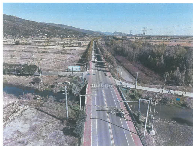
沿线7座桥均存在桥头跳车，主线缺少减速标线，警告标志（分别为山东河桥、小魏
