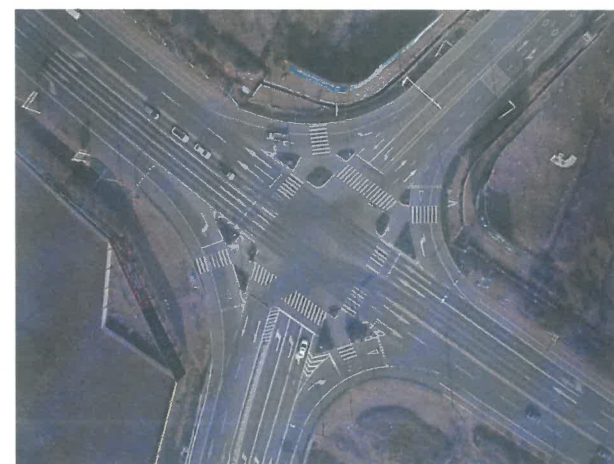
标线磨损、各方向标线原则不统一
