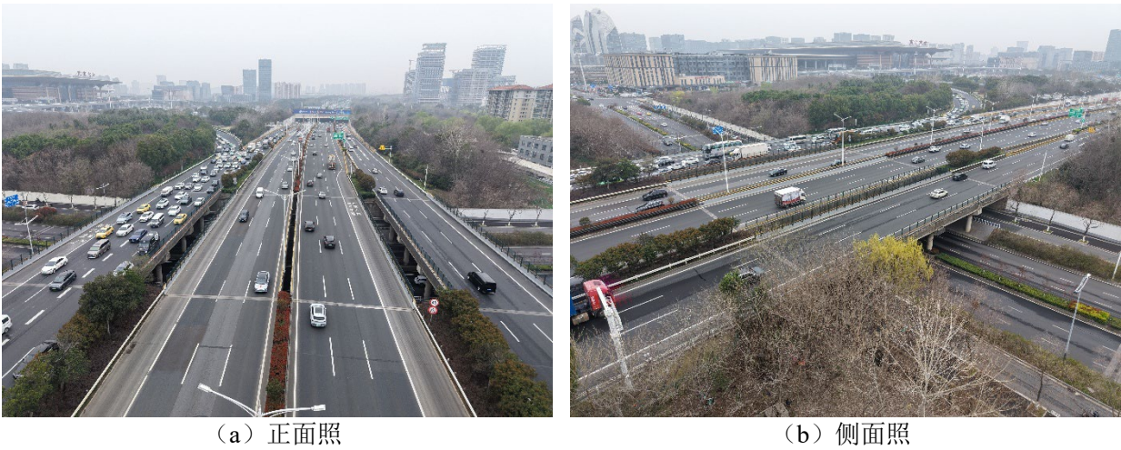
图 1.3-15 G42 站东路桥正侧面照
