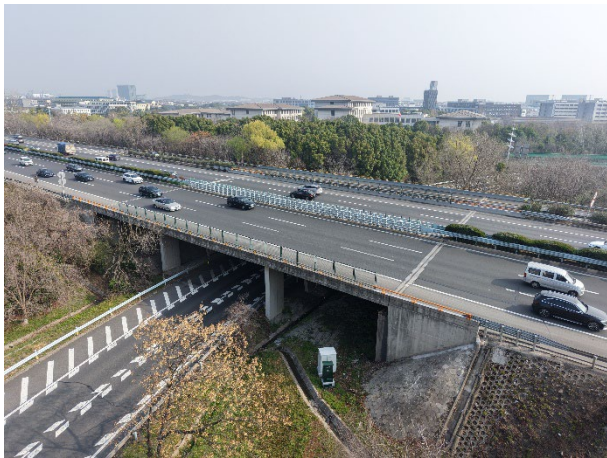
(b) 桥下跨越道路情况
