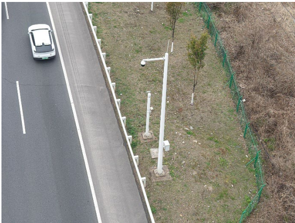
图 3.1-40 既有视频监控点位及现场照片
