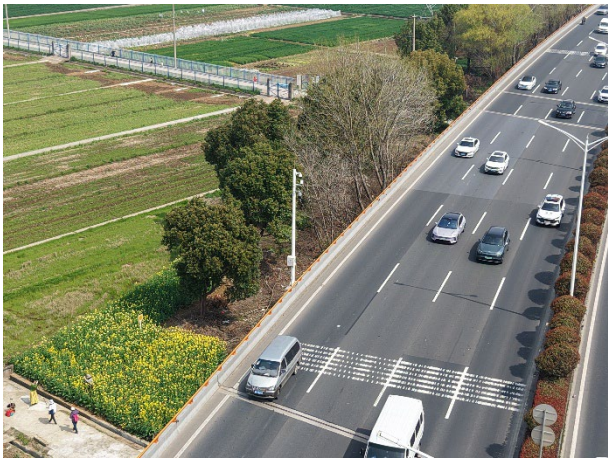
图 3.1-18 既有视频监控点位及现场照片
