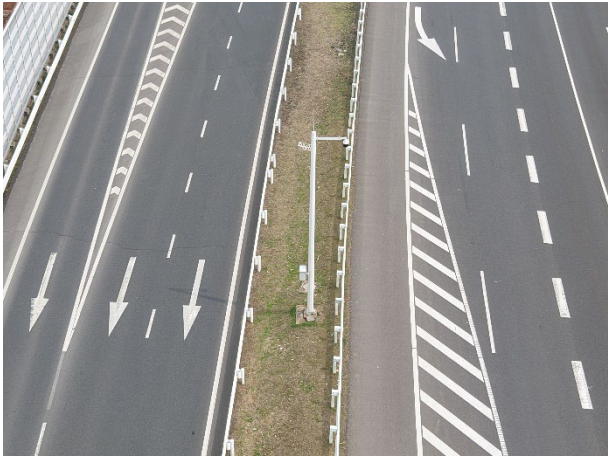
图 3.1-36 既有视频监控点位及现场照片
