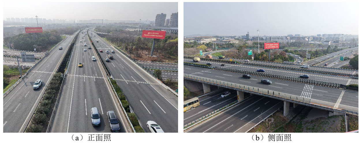
图 1.3-4 G42 马群互通 3 号立交桥正侧面照
