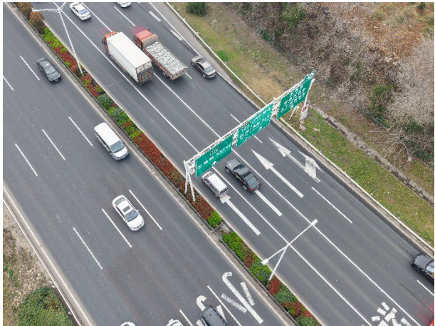
图 3.1-20 既有视频监控点位及现场照片
