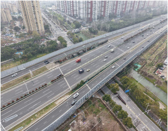
（b）桥下跨越地物情况
