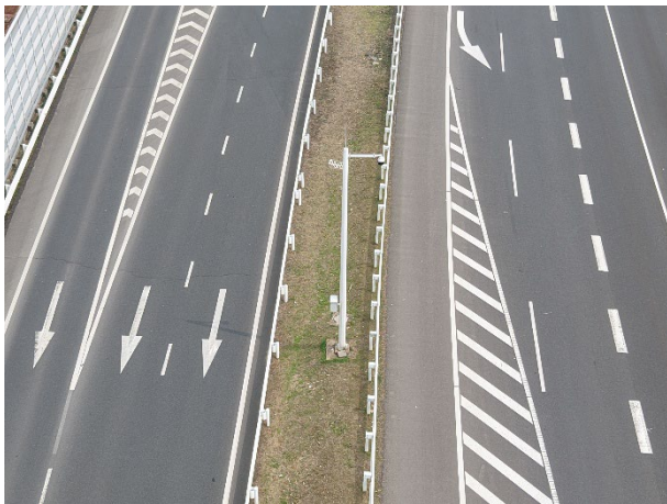
图 3.1-38 既有视频监控点位及现场照片
