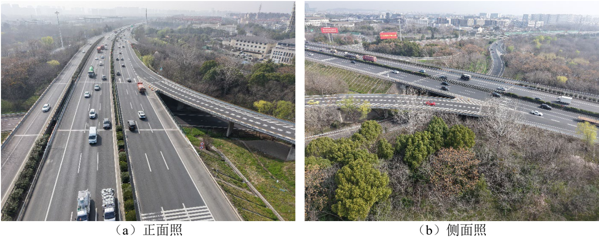
图 1.3-5 G42 马群互通 4 号立交桥正侧面照
