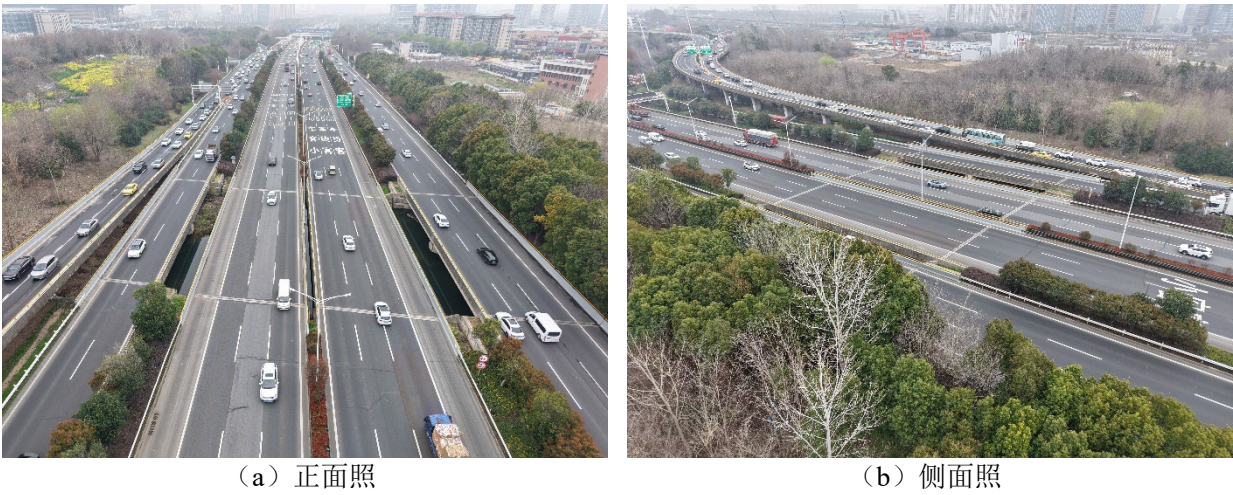
图 1.3-14 G42 站东二路桥正侧面照
