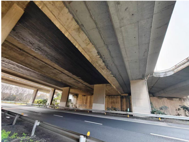
（b）桥下跨越道路情况
