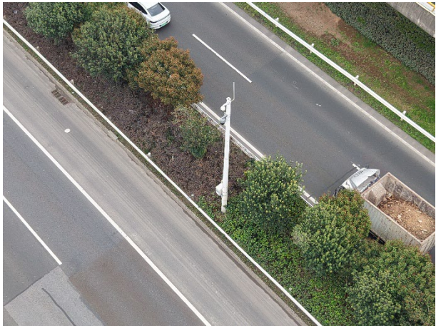
图 3.1-26 既有视频监控点位及现场照片
