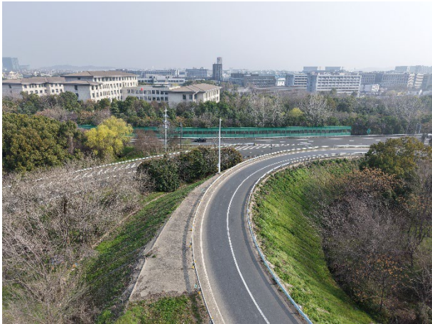
图 3.1-6 既有视频监控点位及现场照片
