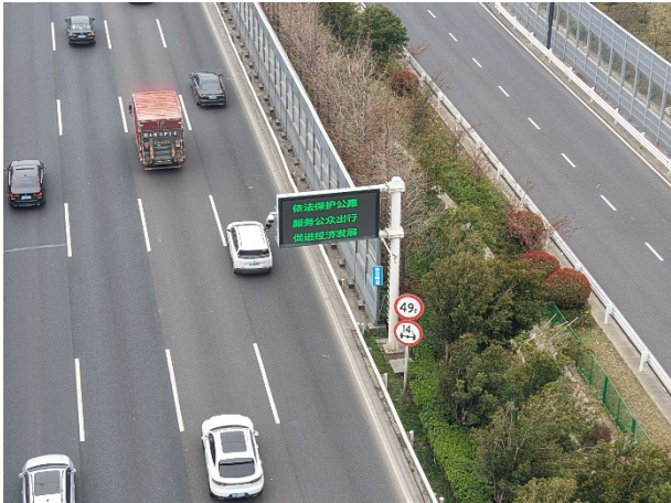
图 3.1-24 既有视频监控点位及现场照片
