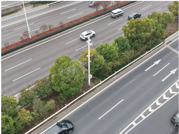
图 3.1-32 既有视频监控点位及现场照片
