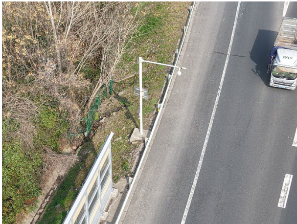
图 3.1-8 既有视频监控点位及现场照片
