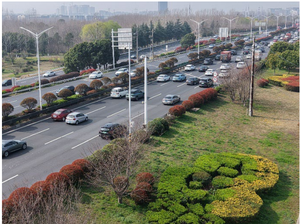
图 3.1-14 既有视频监控点位及现场照片
