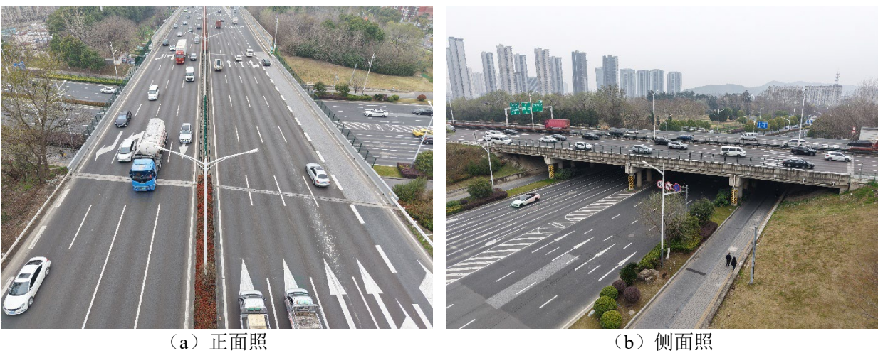
图 1.3-18 G42 铁心桥互通主线桥正侧面照
