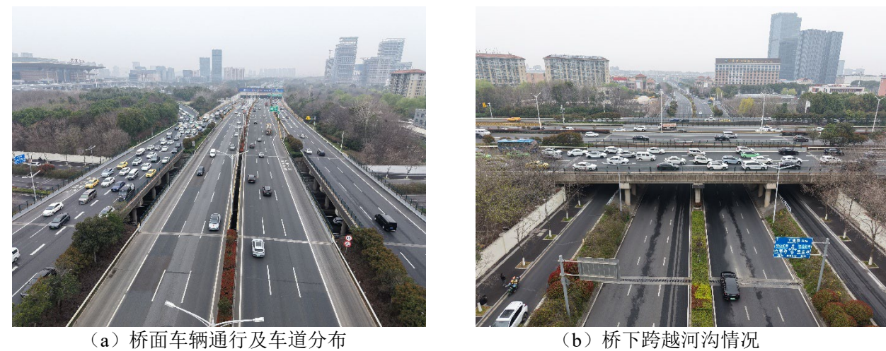
图 3.1-27 G42 站东路桥现场调查情况
