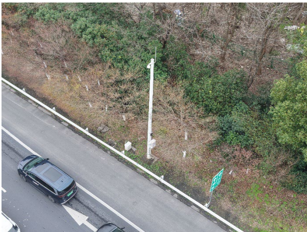
图 3.1-28 既有视频监控点位及现场照片
