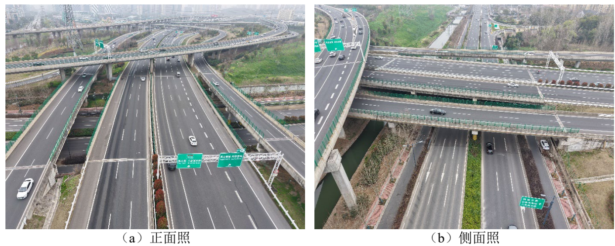
图 1.3-19 G42 经四路互通主线桥正侧面照
