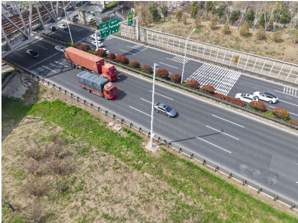
图 3.1-12 既有视频监控点位及现场照片
