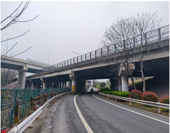
（b）桥下跨越道路情况
