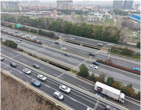
（b）桥下跨越河沟情况
