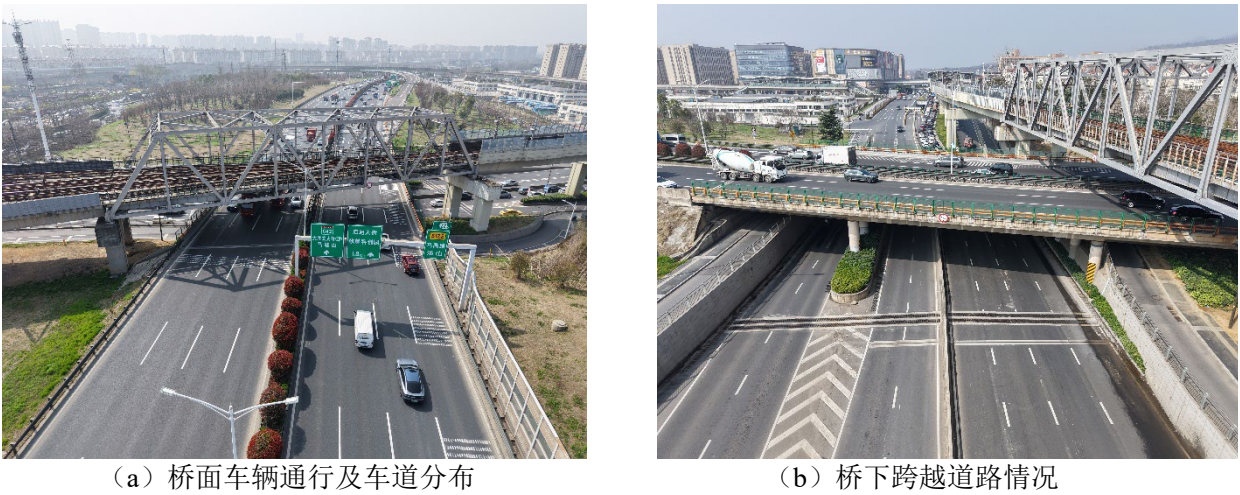
图 3.1-11 G42 万家楼互通主线桥现场调查情况
