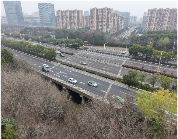
（b）桥下跨越河沟情况
