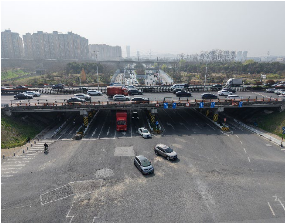
（b）桥下跨越道路情况
