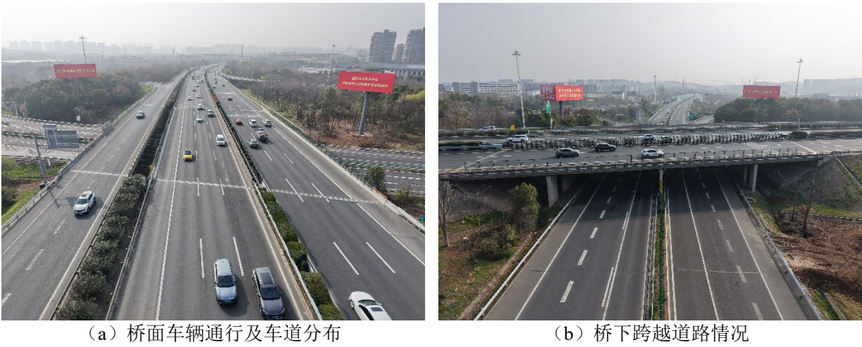
图 3.1-5 G42 马群互通 3 号立交桥现场调查情况
