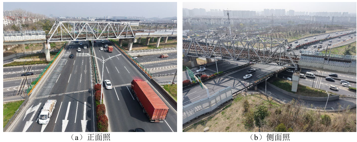
图 1.3-7 G42 万家楼互通主线桥正侧面照
