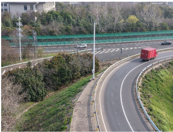
图 3.1-2 既有视频监控点位及现场照片
