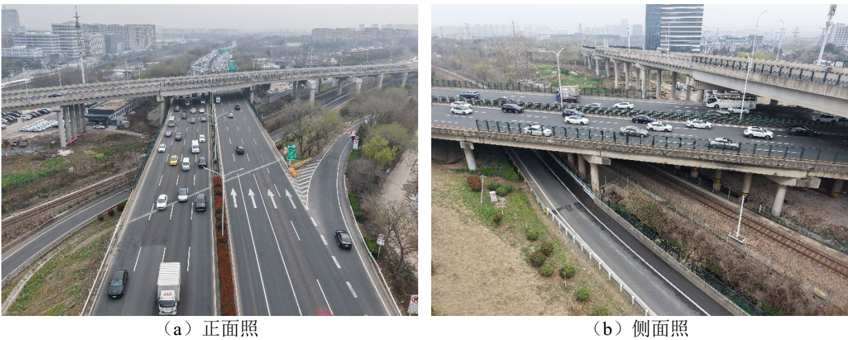
图 1.3-11 G42 五百户互通主线立交大桥正侧面照
