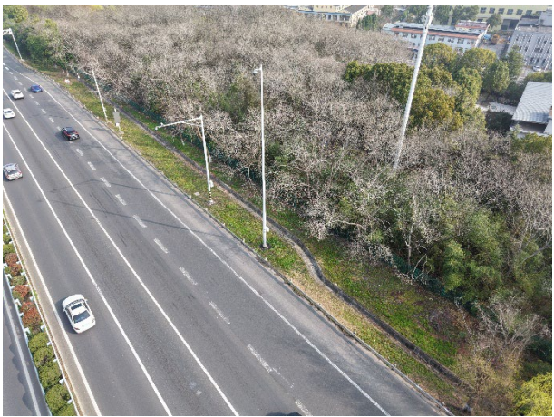
图 3.1-4 既有视频监控点位及现场照片
