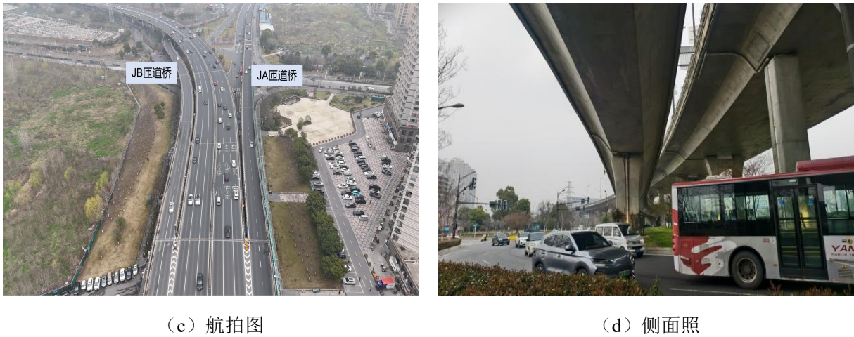
图 3.1-23 顶山互通立交桥 JB 匝道桥
