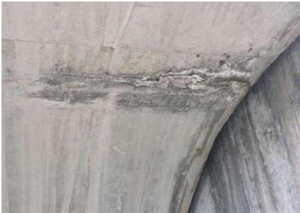
(b) 13-1#箱梁右翼缘板，距 13#台 0m 处，锈胀
