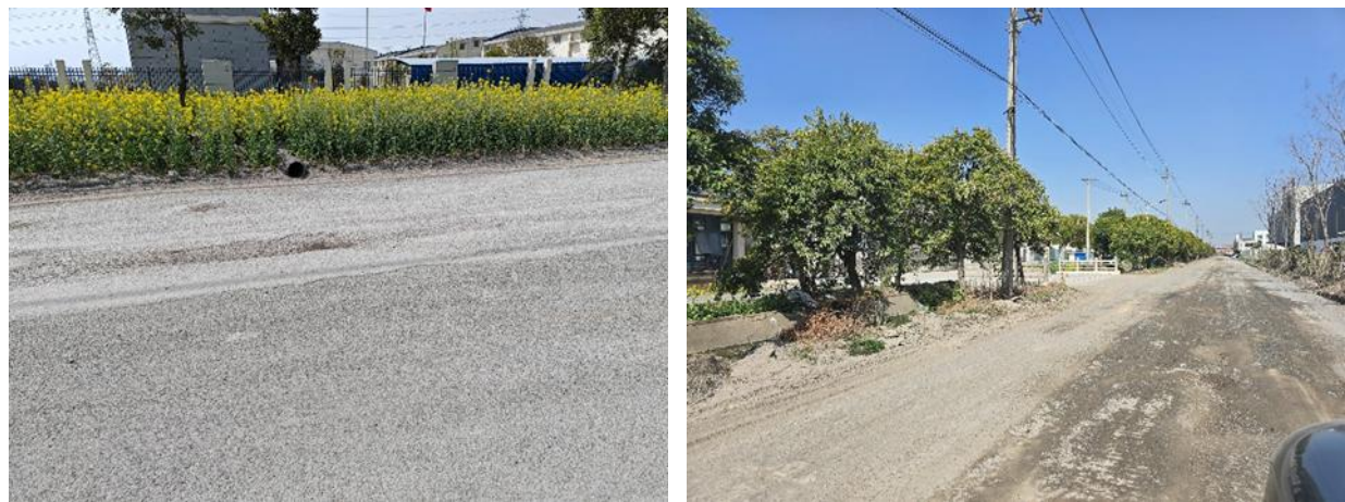
图 2-13 起点至 K0+413 段排水现状
