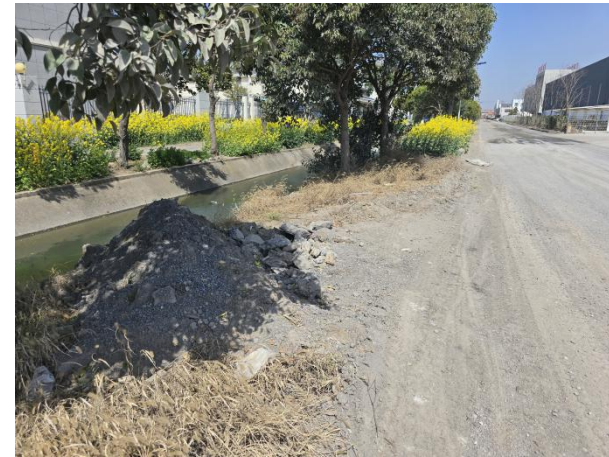
图 2-19 路侧未设置波形梁护栏
