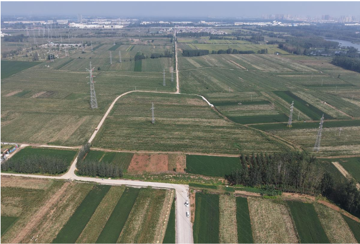
1#涵洞现状照片
