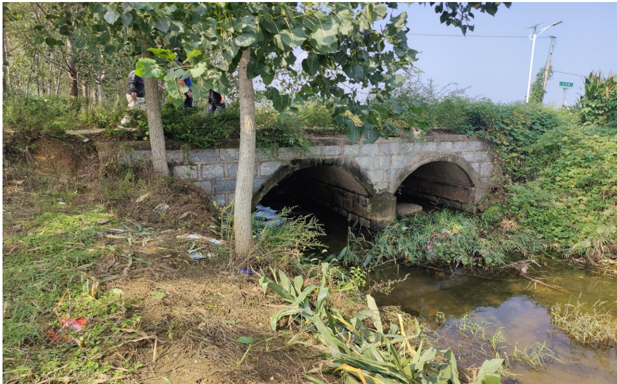
2#涵洞拆除新建现状照片
