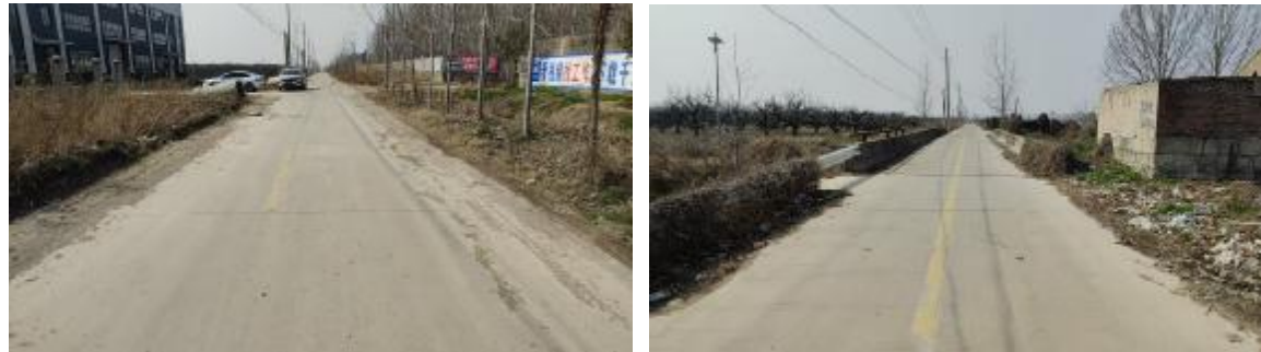
图 3-1 水泥路面现状
