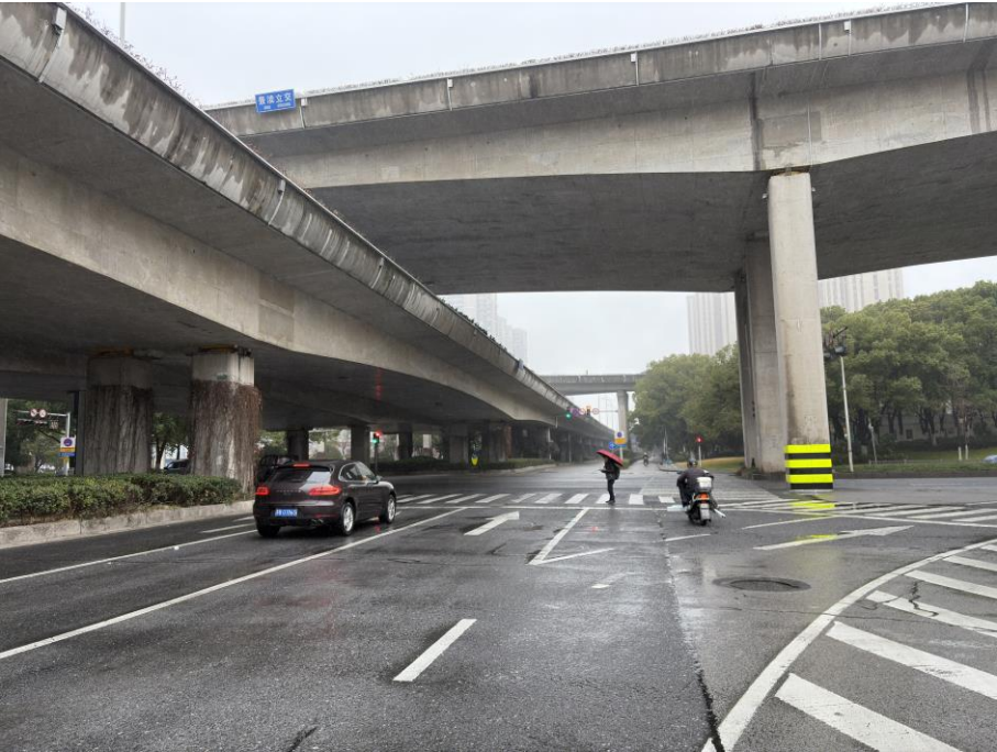
景渎立交路口桥墩现场情况（江海路方向、北往南）
