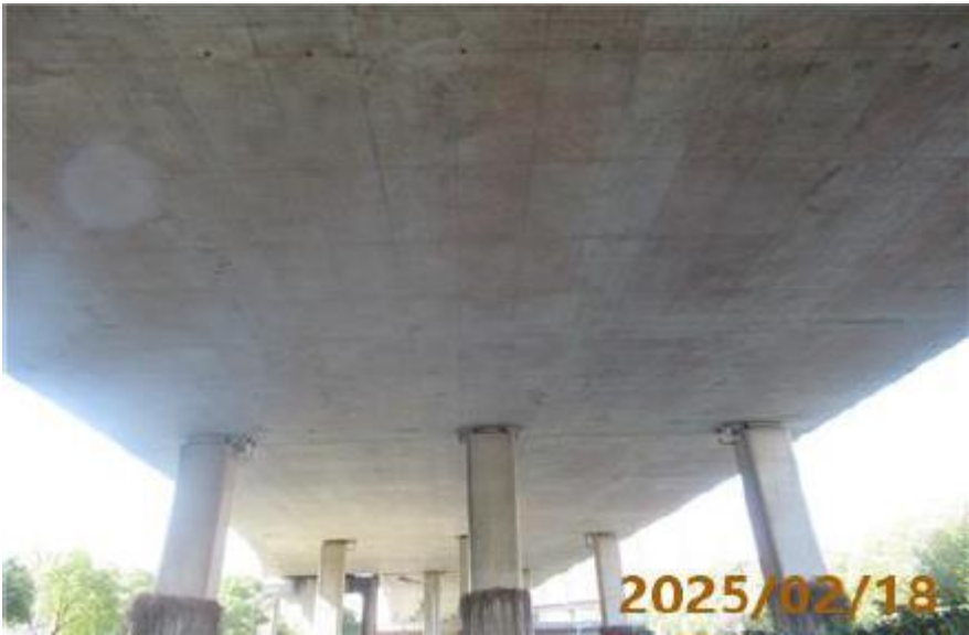
景洩立交金城路主线底面实景图
