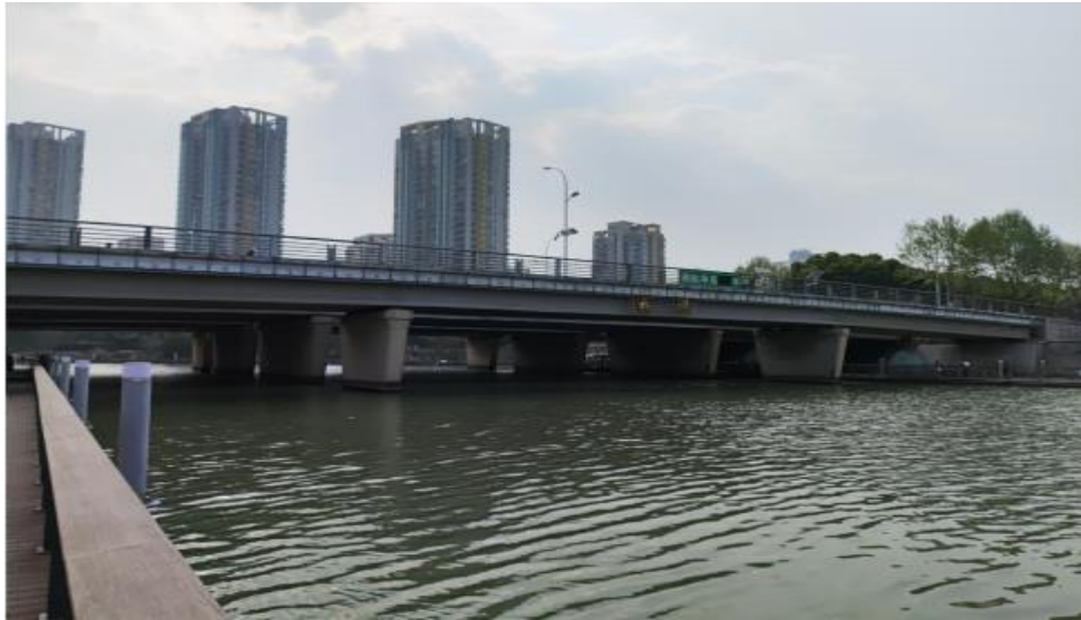
现状桥梁侧面
