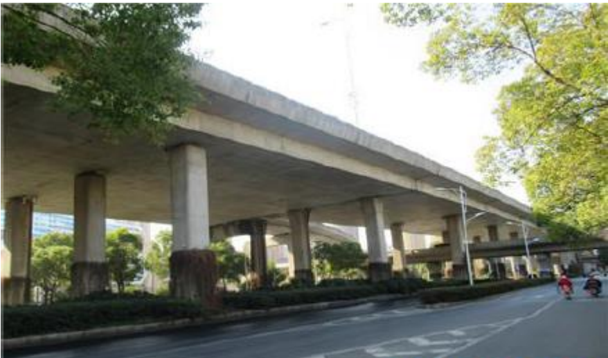
景洩立交金城路主线侧面实景图
