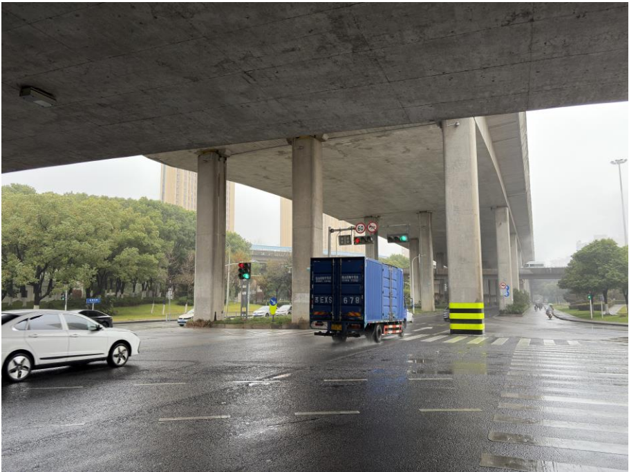
景渎立交路口桥墩现场情况（金城路方向、西往东）
