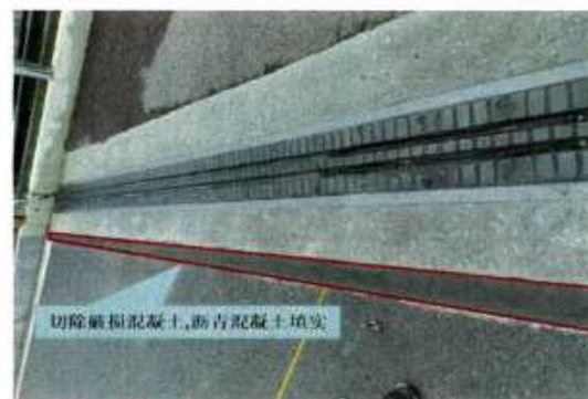
锚固区破损混凝土修复
