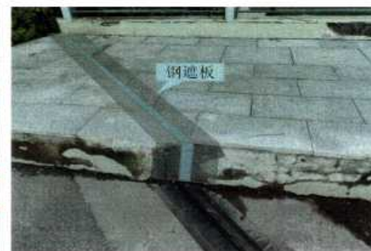
人行道伸缩缝修复
