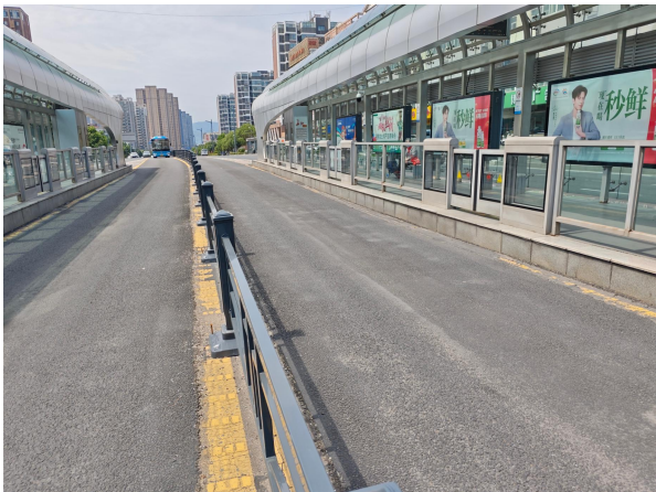
图3-8 现状BRT站台
