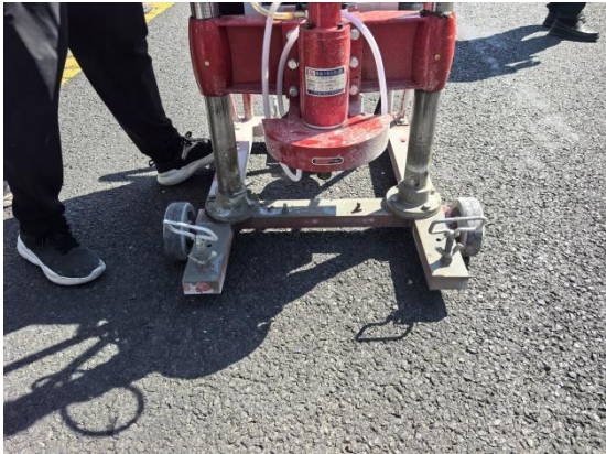
K8+300 左幅 BRT 车道 路面完好处
