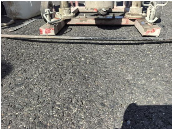
K6+800 左幅 BRT 车道（嘉瑞宝）车辙凹点处
