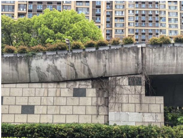
挡墙与防撞墙之间缝隙
