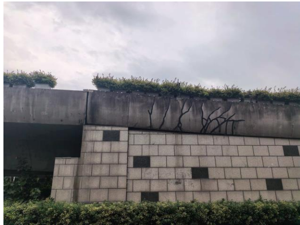
挡墙与防撞墙之间缝隙
