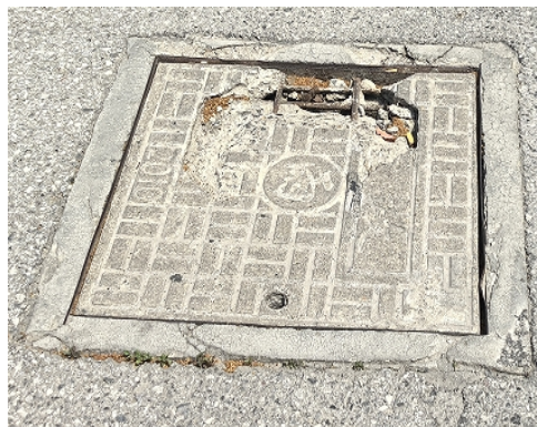
现状检查井井盖座破损
