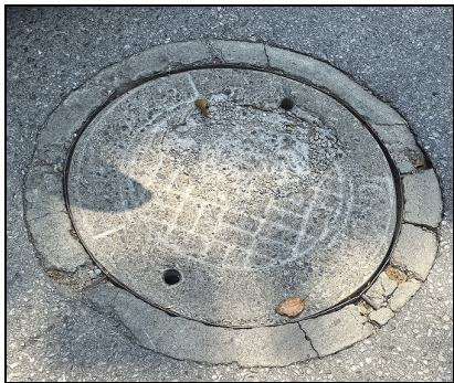
雨水箅子堵塞、雨污水井盖座破损
