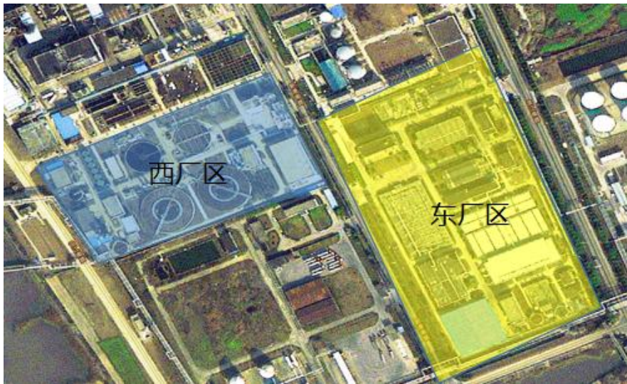
图 2.4.2-2 泰兴市滨江污水处理厂
