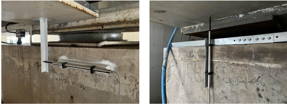
图 6.5-6 顶杆位移计现场照片
