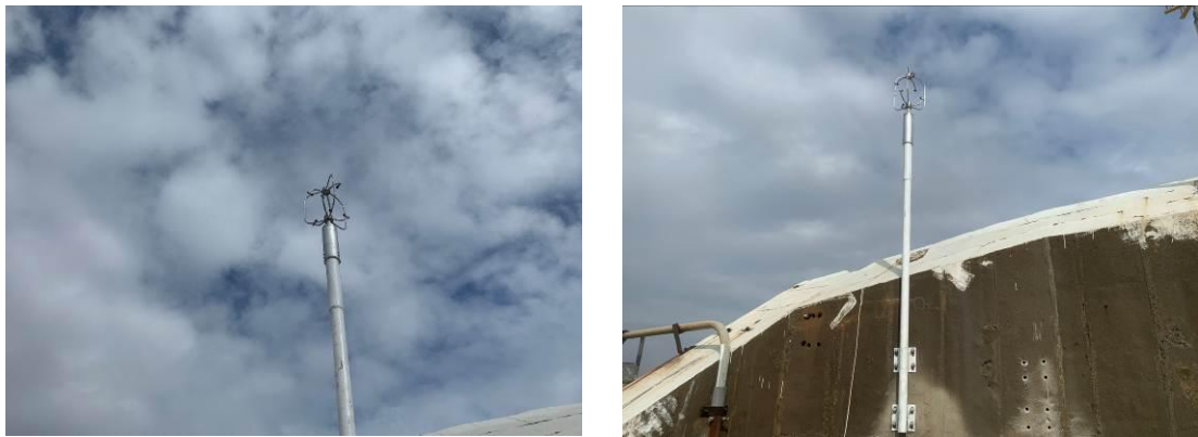
图 6.5-1 风速风向仪现场照片
