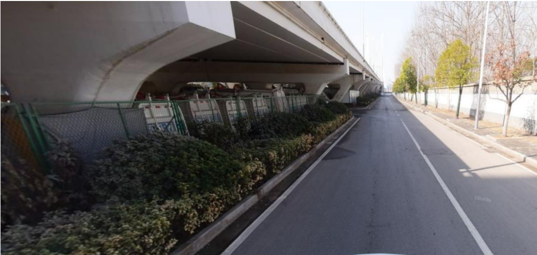
和平大桥桥侧道路情况
